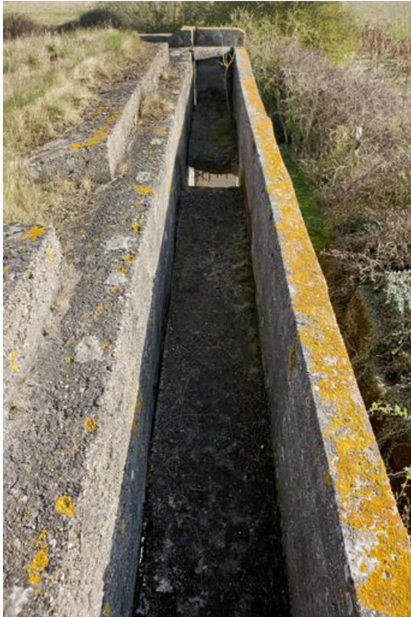
La tranchée surélevée, vue plongeante vers l'est
