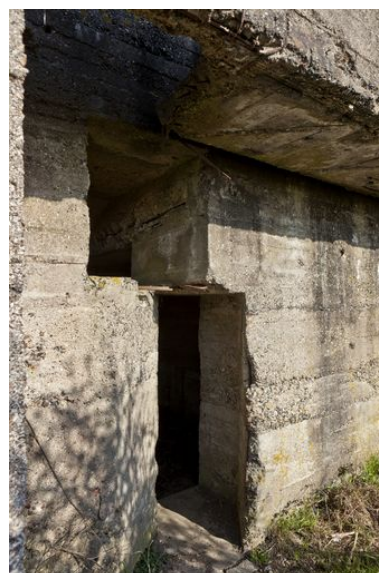
Elévation sud. Entrée secondaire et passage des canalisations d'eau, vers le nord-est. Phot. Jean-Marc Ramette IVR31_20145905408NUCA
