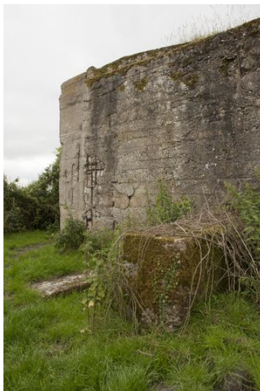
Elévation ouest Phot. Jean-Marc Ramette IVR31_20145905400NUCA
