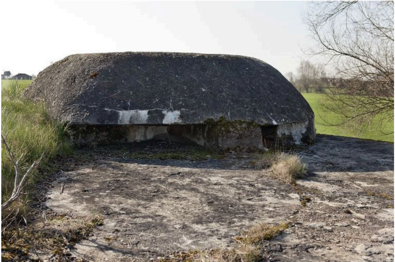
L'observatoire bétonné, vue de détail, vers le sud-ouest
