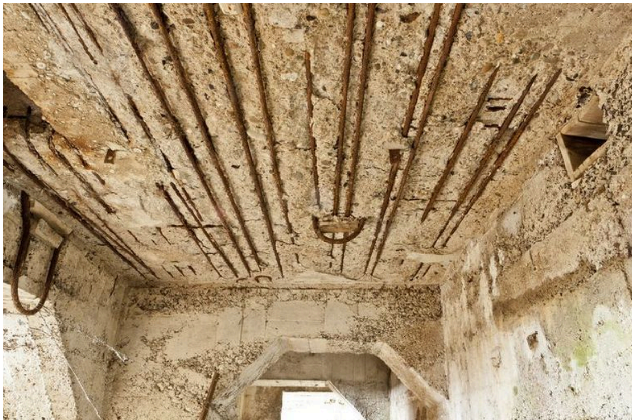
Couloir, détail du couvrement
