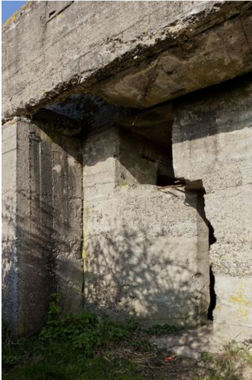
Elévation sud. Entrée secondaire et passage des canalisations d'eau, vers le nord-ouest
