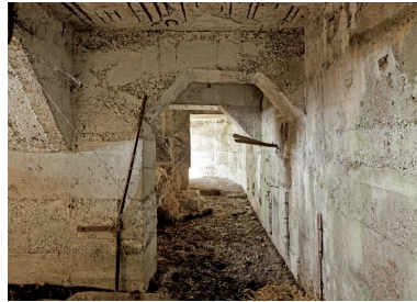
Couloir, vers l'ouest Phot. Jean-Marc Ramette IVR31_20145905429NUCA
