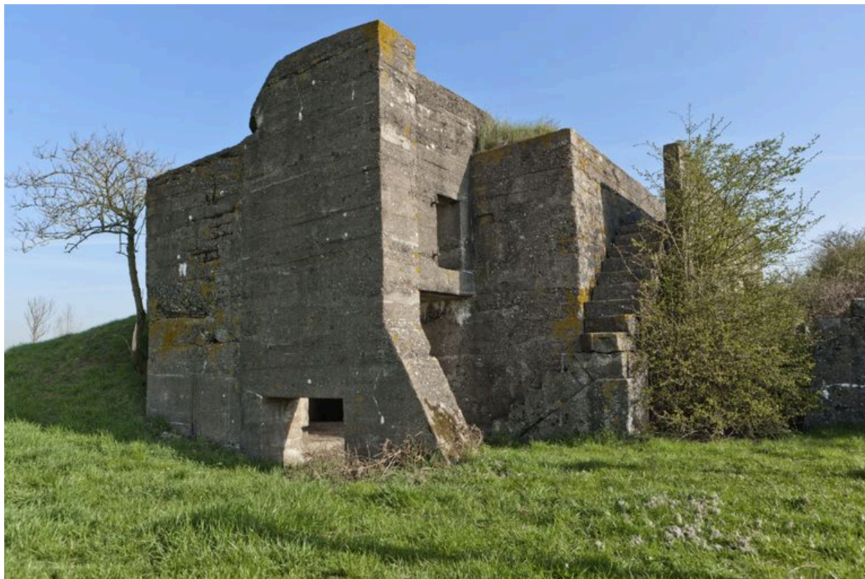
Vue vers le nord-est. Entrée, à gauche, accès à l'observatoire bétonné et escalier menant à la tranchée surélevée
