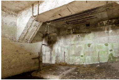
Salle secondaire, socle bétonné et accès à la salle principale Phot. Jean-Marc Ramette IVR31_20145905427NUCA
