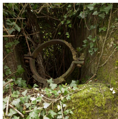
Au sud de l'édifice, collier de fixation d'un des conduits d'évacuation Phot. Jean-Marc Ramette IVR31_20145905403NUCA
