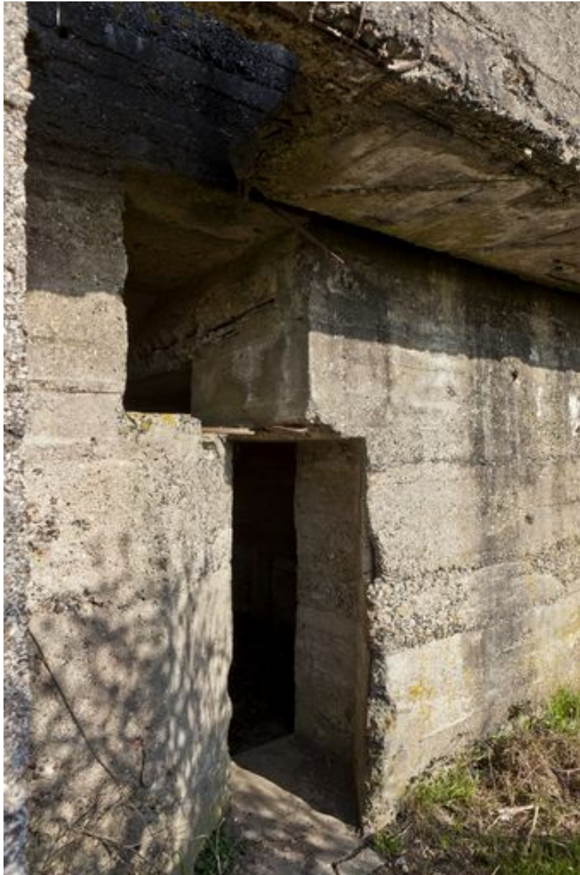
Elévation sud. Entrée secondaire et passage des canalisations d'eau, vers le nord-est.
