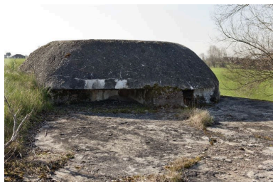
L'observatoire bétonné, vue de détail, vers le sud-ouest Phot. Jean-Marc Ramette IVR31_20145905417NUCA
