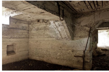
salle secondaire, détail de couvrement en béton armé, vers sud-ouest Phot. Jean-Marc Ramette IVR31_20145905430NUCA
