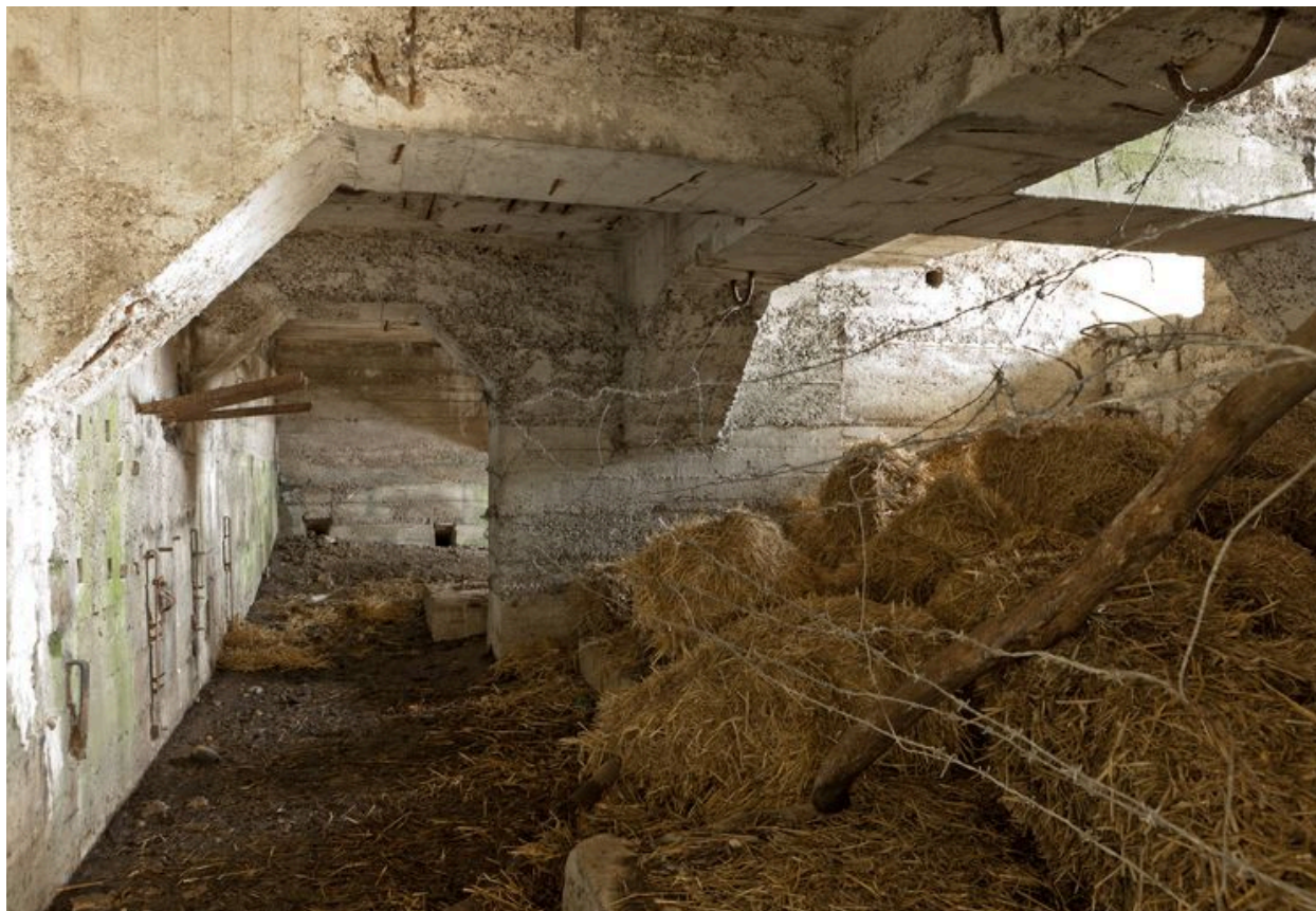
Vue intérieure, vers l'est
