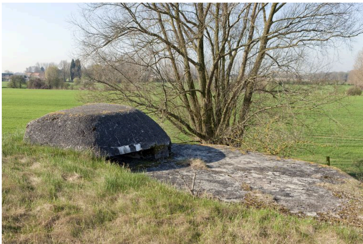
L'observatoire bétonnées, vers l'ouest.
