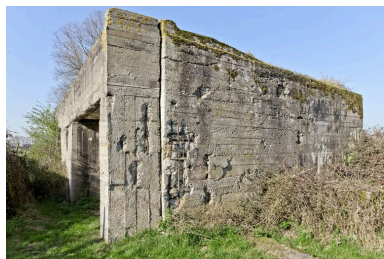
Vue générale vers le nord-ouest Phot. Jean-Marc Ramette IVR31_20145905405NUCA
