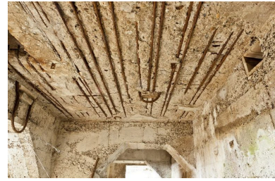
Couloir, détail du couvrement Phot. Jean-Marc Ramette IVR31_20145905431NUCA
