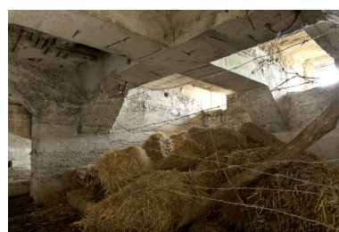
Salle principale, vue du couvrement en béton armé Phot. Jean-Marc Ramette IVR31_20145905424NUCA
