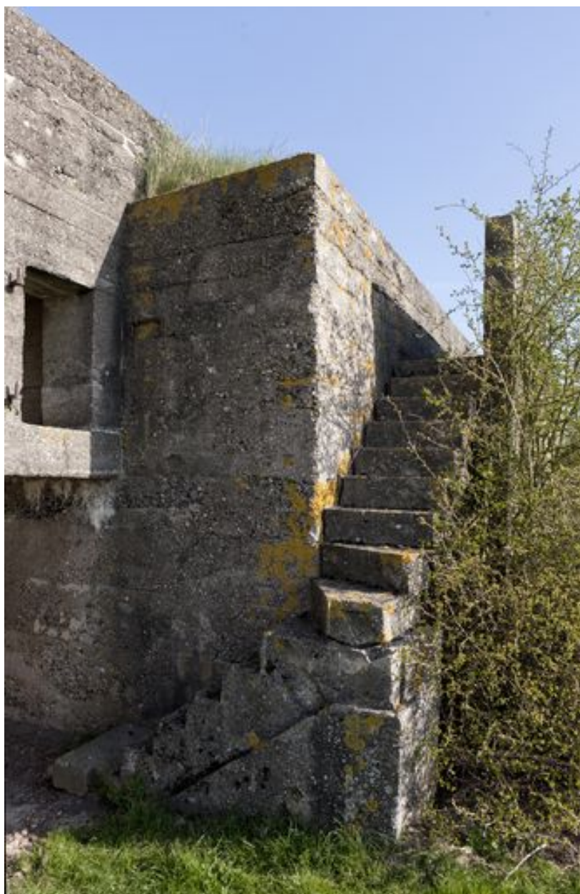
Accès à l'observatoire bétonnée (à gauche) et escalier menant à la tranchée surélevée.
