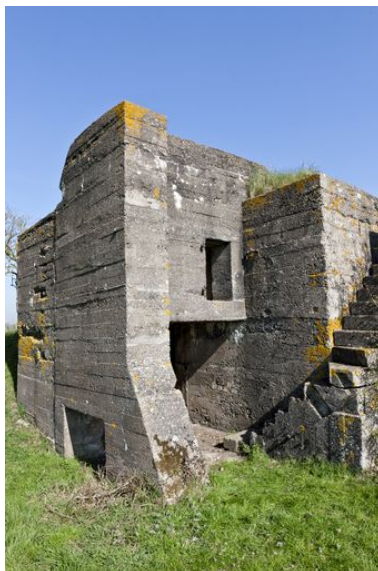
Elévation sud, entrée principale. Phot. Jean-Marc Ramette IVR31_20145905435NUCA
