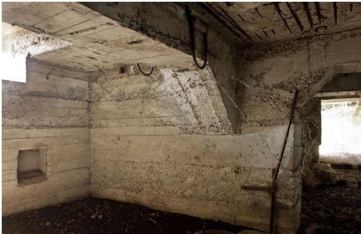
salle secondaire, détail de couverture en béton armé, vers sud-ouest
