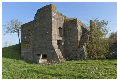
Vue vers le nord-est. Entrée, à gauche, accès à l'observatoire bétonné et escalier menant à la tranchée surélevée Phot. Jean-Marc Ramette IVR31_20145905437NUCA
