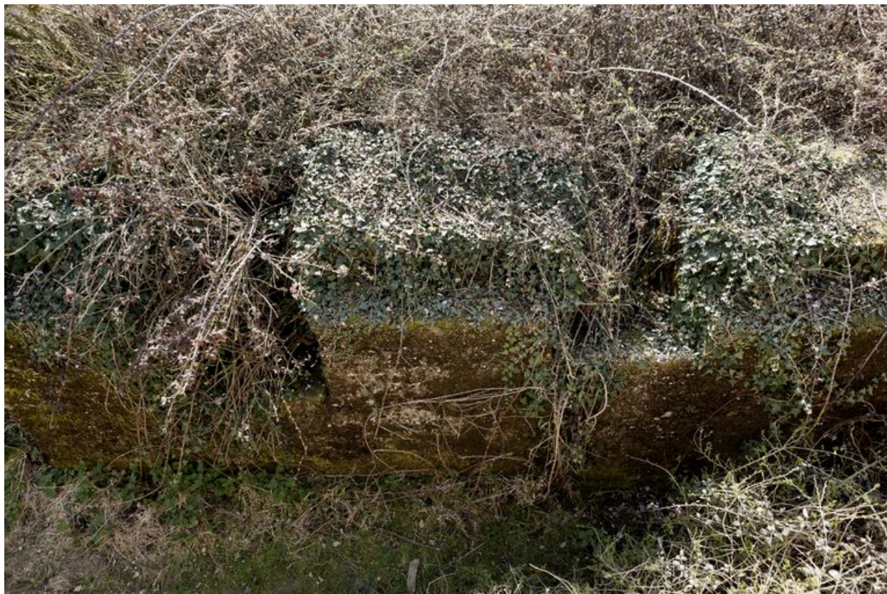
Au sud de l'édifice, massif de fixation des conduits d'évacuation d'eau
