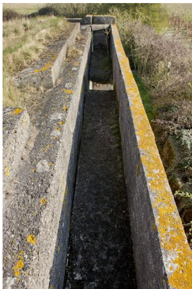
La tranchée surélevée, vue plongeante vers l'est Phot. Jean-Marc Ramette IVR31_20145905421NUCA
