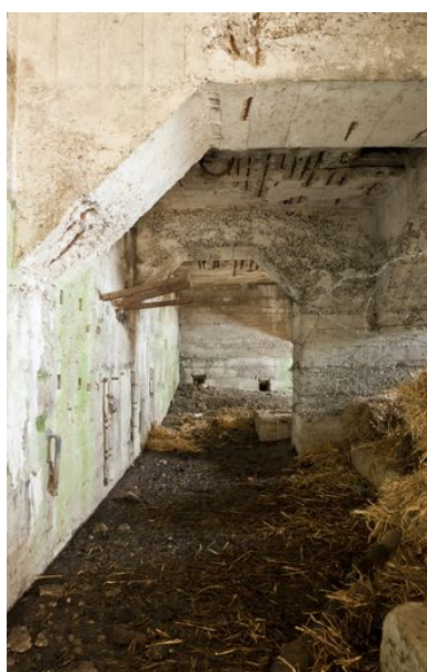
Salle principale, couloir vers l'est Phot. Jean-Marc Ramette IVR31_20145905425NUCA
