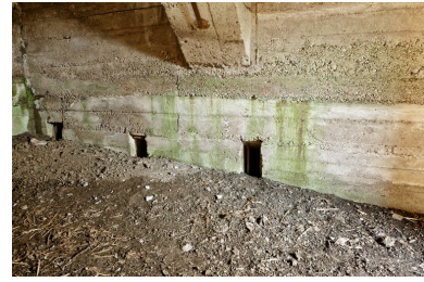
Salle secondaire, ouvertures à la base du mur est. Phot. Jean-Marc Ramette IVR31_20145905432NUCA
