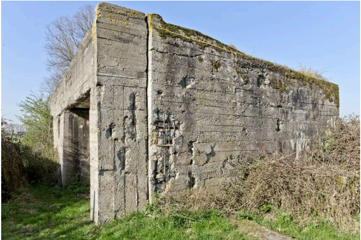
Vue générale vers le nord-ouest
