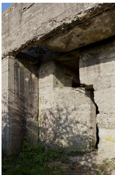
Elévation sud. Entrée secondaire et passage des canalisations d'eau, vers le nord-ouest Phot. Jean-Marc Ramette IVR31_20145905407NUCA
