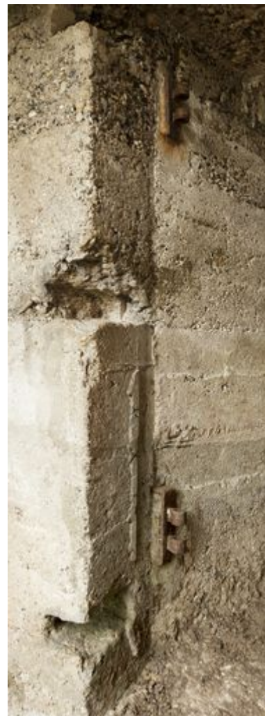
Gonds au niveaux de l'accès principale Phot. Jean-Marc Ramette IVR31_20145905404NUCA
