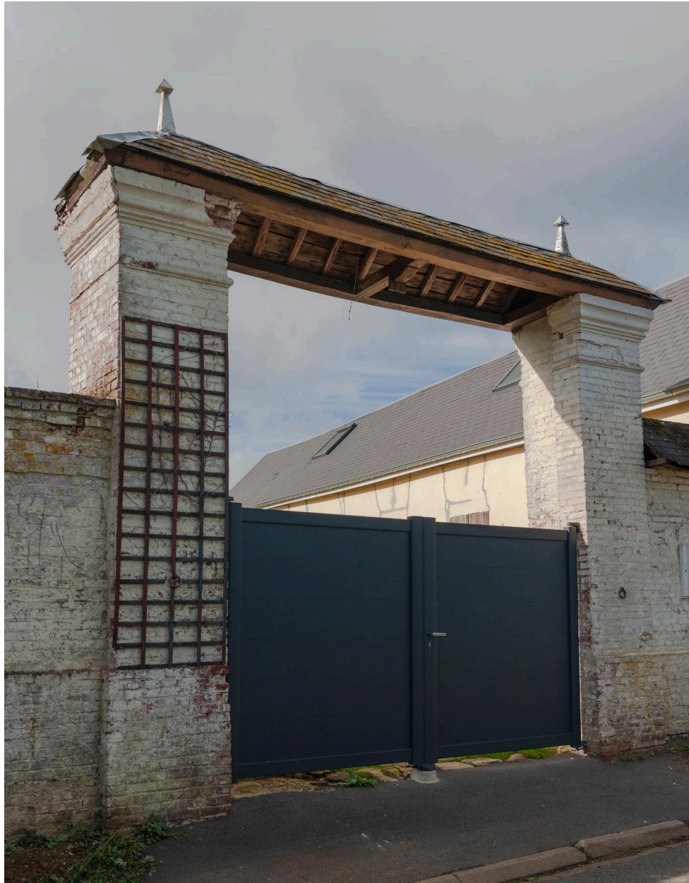
Portail, n°109 rue des Marronniers, vue depuis le sud-est.
