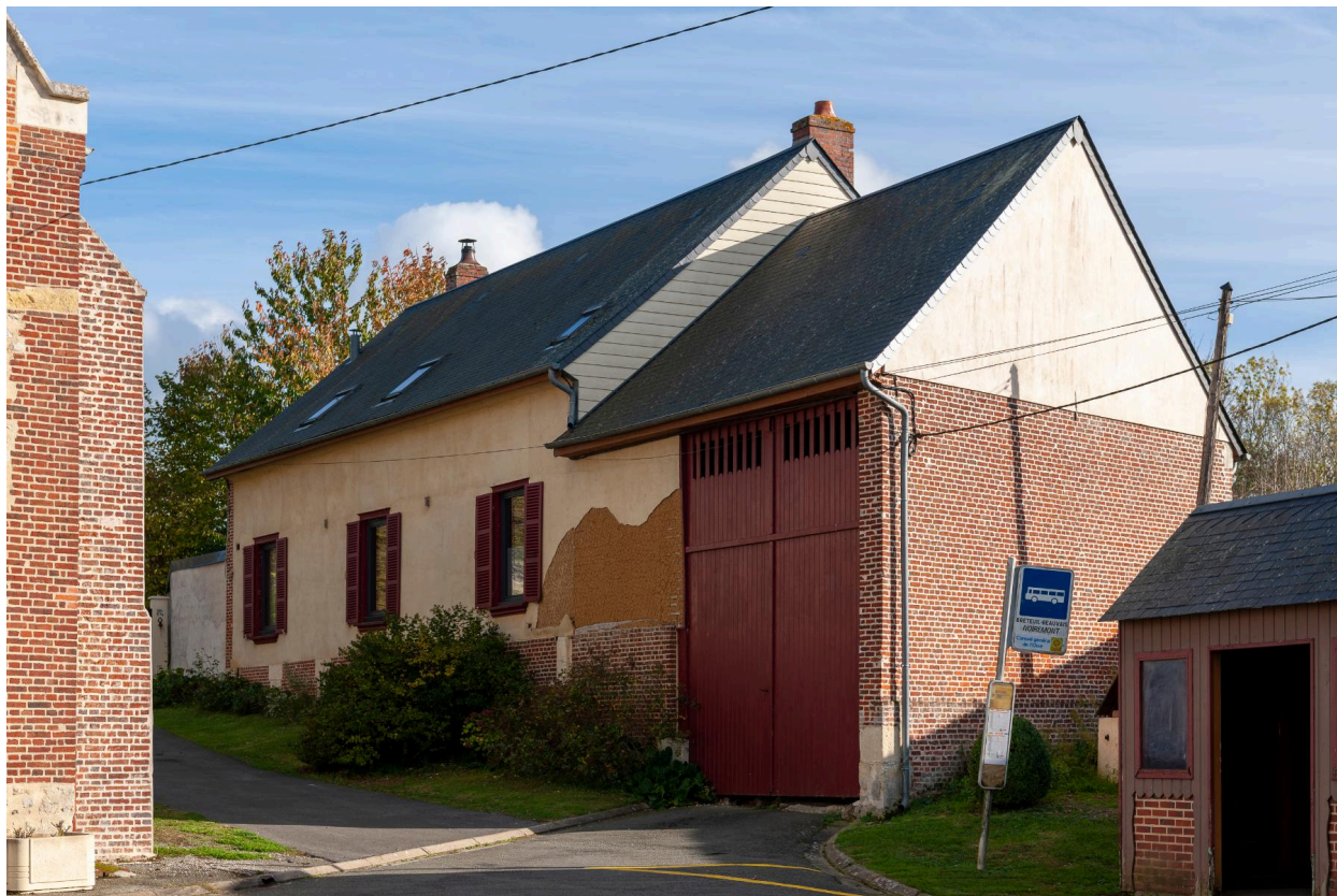
Logis sur rue avec entrée charretière d'une ferme à cour, n°13 Place de l'Église, vue depuis le nord.
