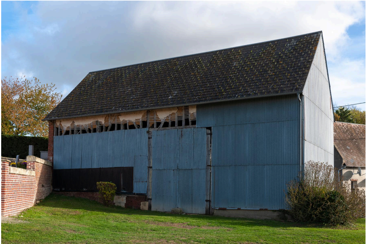
Grange, rue de Beauvais, vue depuis le nord-ouest.
