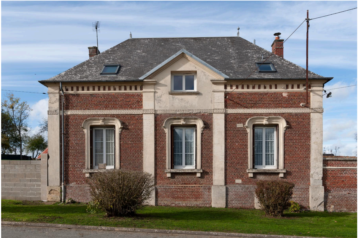
Maison, n°382 rue de Beauvais, vue depuis l'est.
