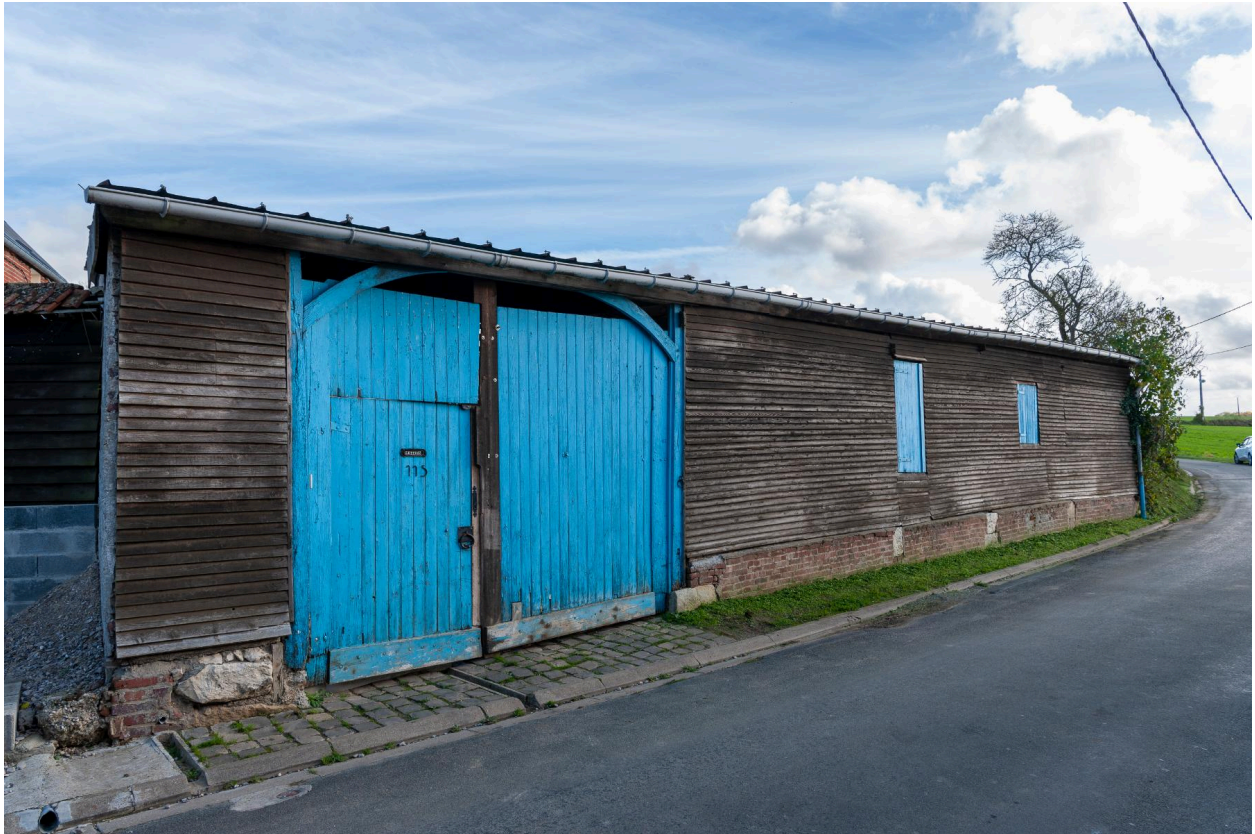
Grange sur rue, n°115 rue des Glycines, vue depuis l'ouest.
