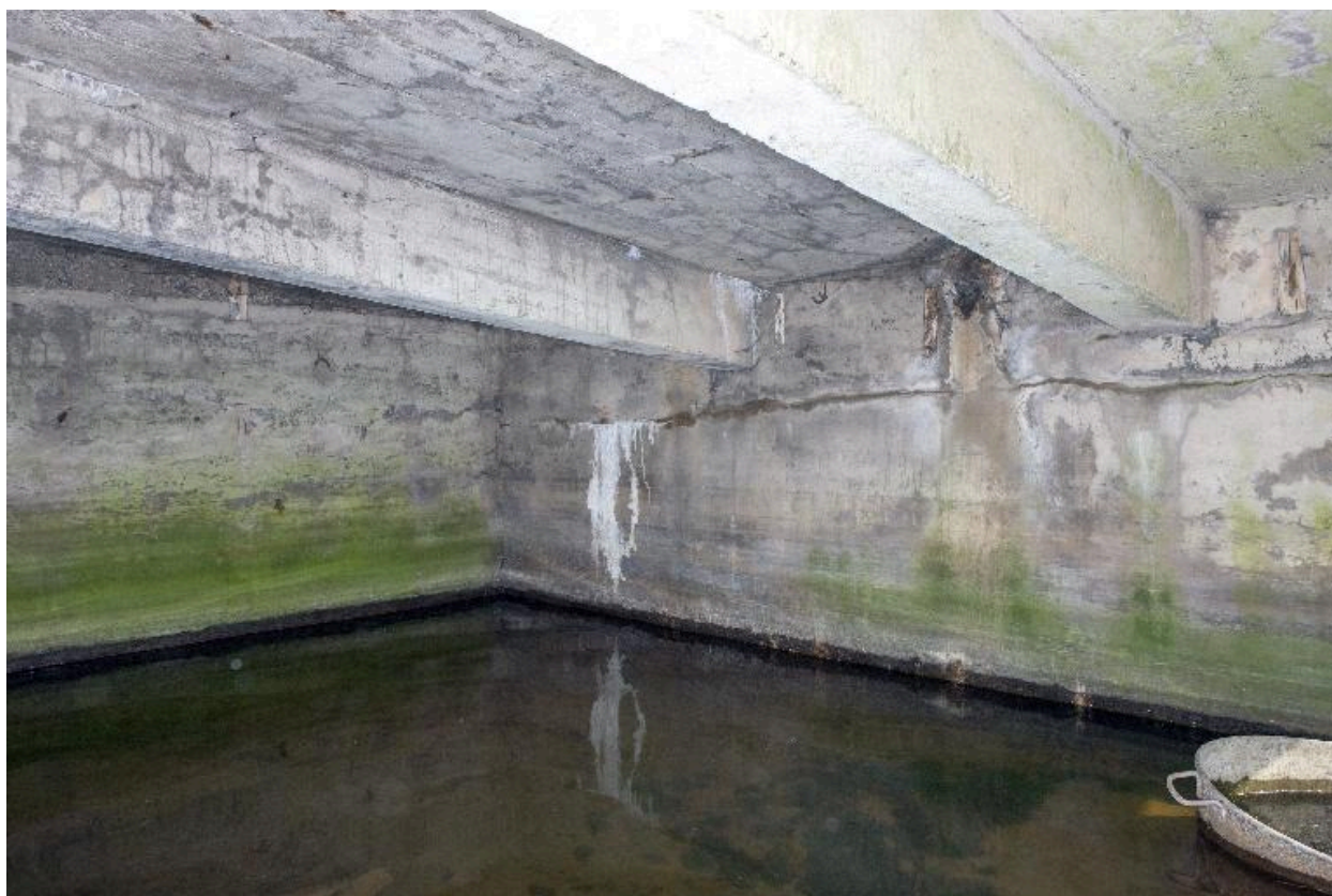
Vue intérieure de la soute à munitions
