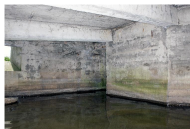
La soute à munitions. Au fond, à droite, l'accès à la chambre de tir Phot. Jean-Marc Ramette IVR31_20155901180NUCA
