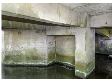
Vue intérieure de la chambre de tir, vers la soute à munitions Phot. Jean-Marc Ramette IVR32_20175900503NUCA
