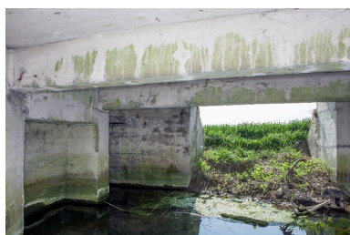
Vue intérieure de la chambre de tir, vers l'arrière. A gauche, accès à la soute à munitions Phot. Pierre Thibaut IVR31_20155901172NUCA
