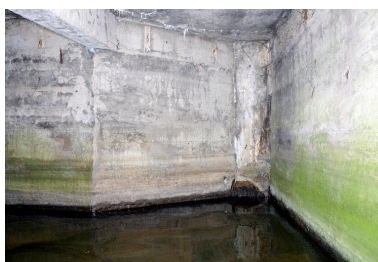
Mur externe de la chambre de tir, depuis la soute à munitions Phot. Pierre Thibaut IVR31_20155901181NUCA
