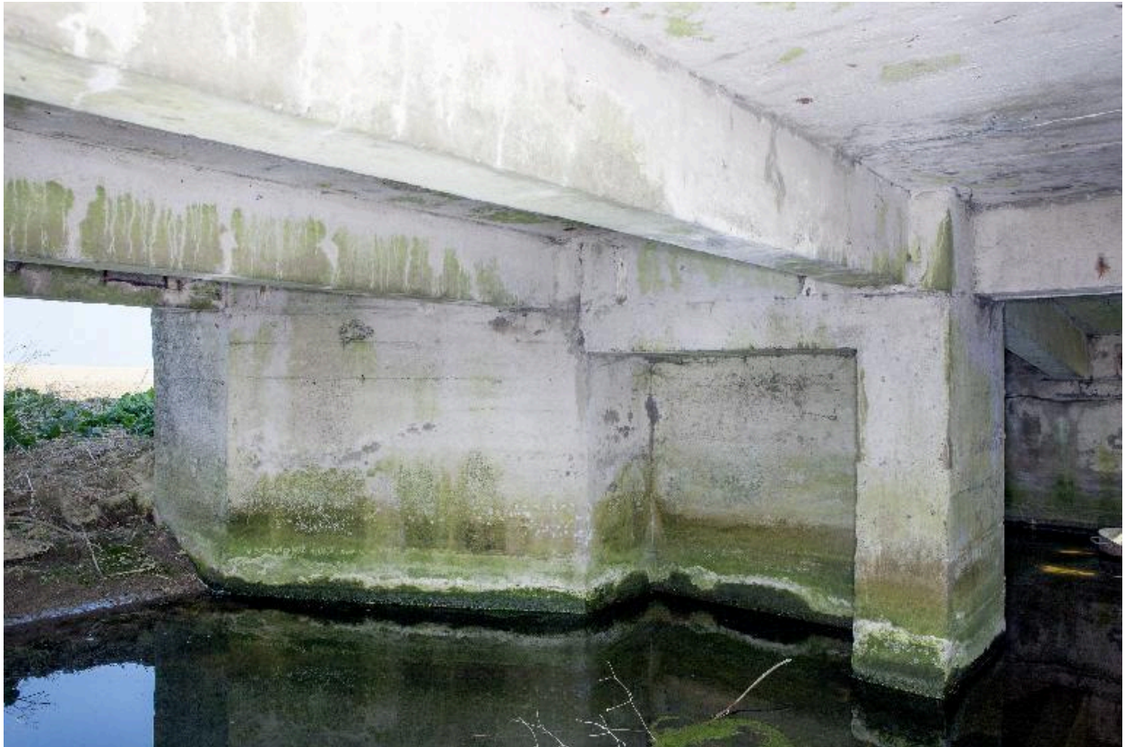
Vue intérieure de la chambre de tir, à droite, l'accès à la soute à munitions
