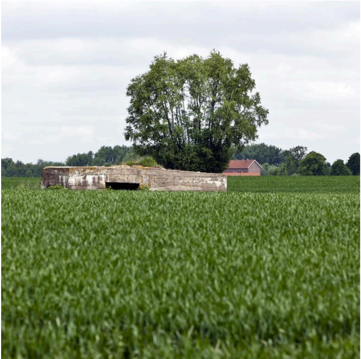
Elévation antérieure, vers le nord-ouest
