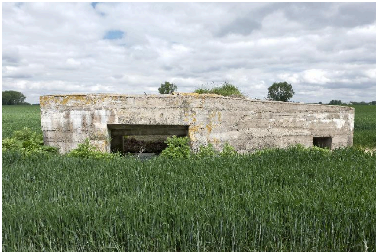
Elévation antérieure dans l'axe de la chambre de tir. A droite la fenêtre de la soute à munitions
