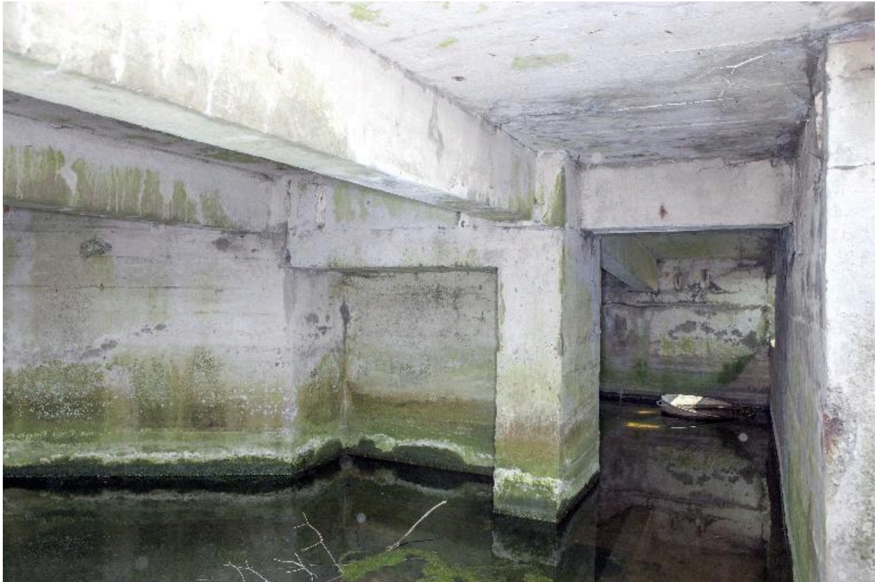
Vue intérieure de la chambre de tir, vers la soute à munitions
