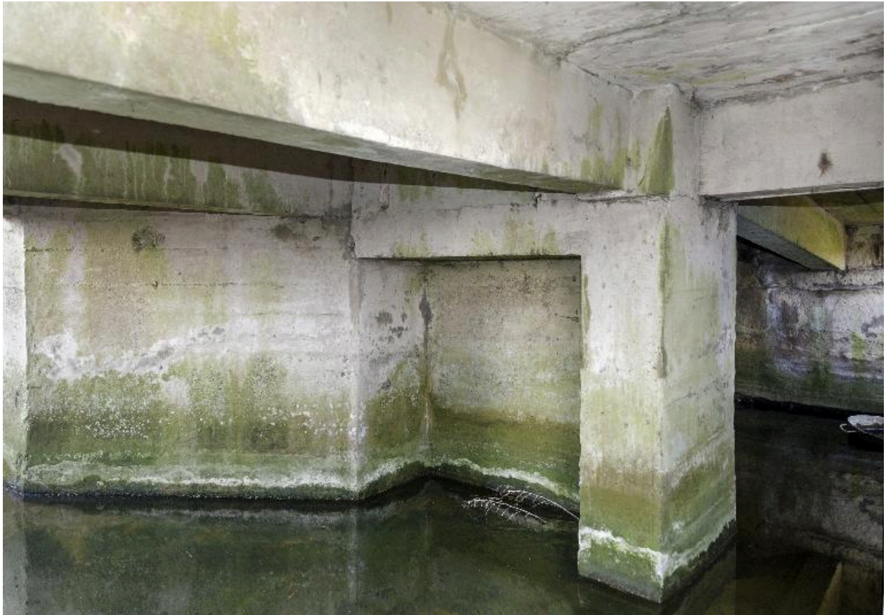
Vue intérieure de la chambre de tir, vers la soute à munitions
