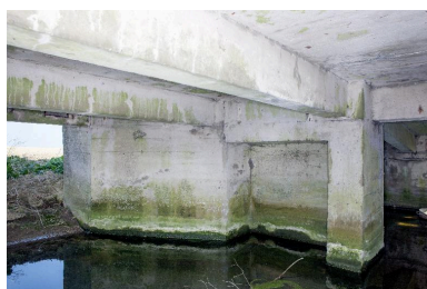
Vue intérieure de la chambre de tir, à droite, accès à la soute à munitions Phot. Jean-Marc Ramette IVR31_20155901175NUCA
