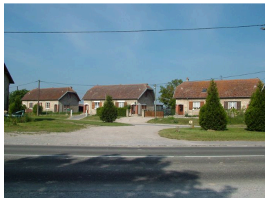
Vue générale. Phot. Inès Guérin IVR22_20030202065NUCA
