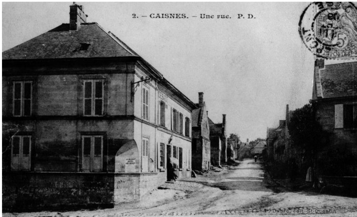
Vue d'une rue du village, avant 1914 (AP).
