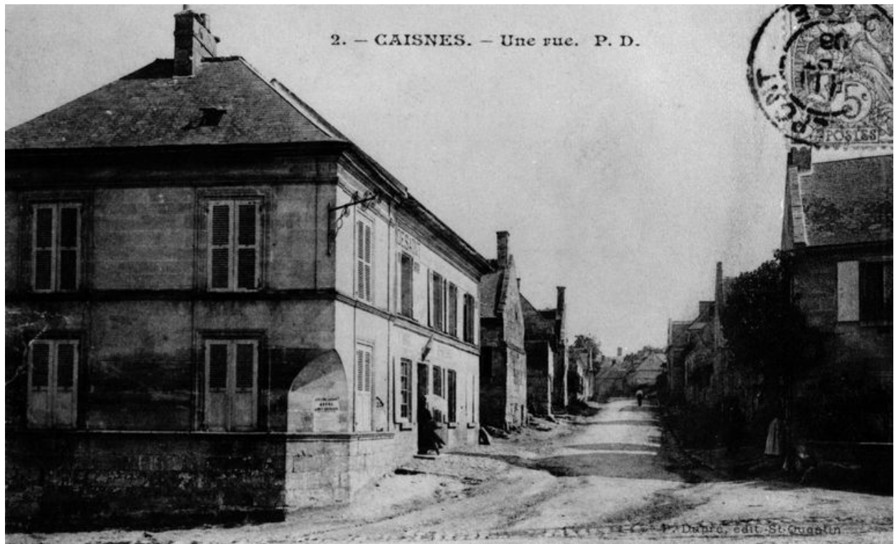
Vue d'une rue du village, avant 1914 (AP).
