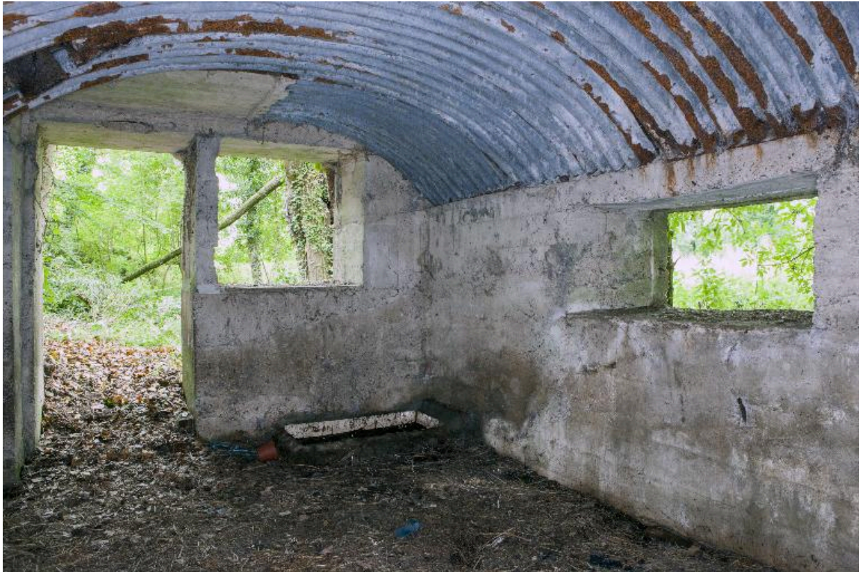
Casemate à personnel
