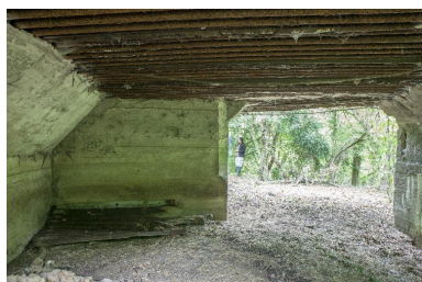
Sortie de la chambre de tir Phot. Pierre Thibaut IVR32_20165901065NUCA
