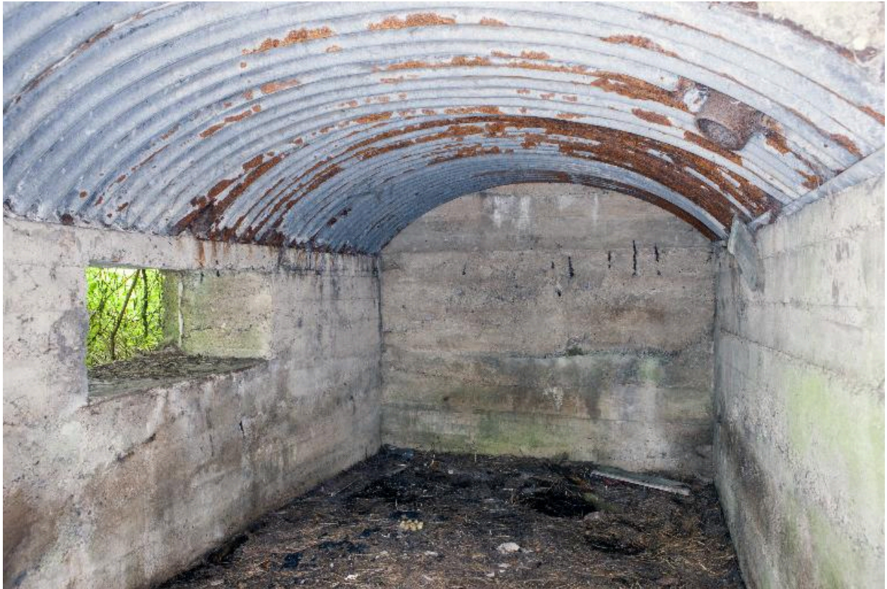
Casemate à personnel vers l'est
