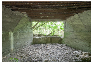
Sortie de la chambre de tir Phot. Pierre Thibaut IVR32_20165901064NUCA
