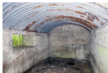
Casemate à personnel vers l'est Phot. Pierre Thibaut IVR32_20165901072NUCA
