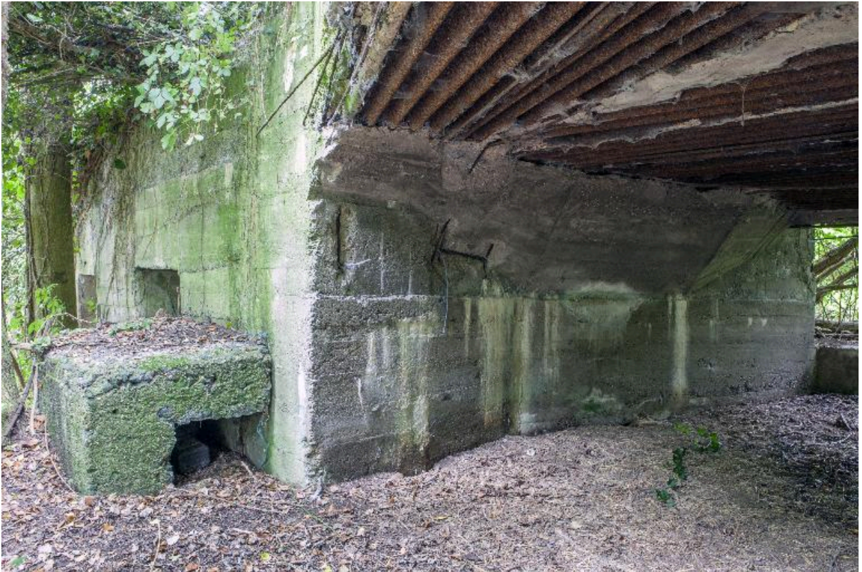
Profil sud de la chambre de tir
