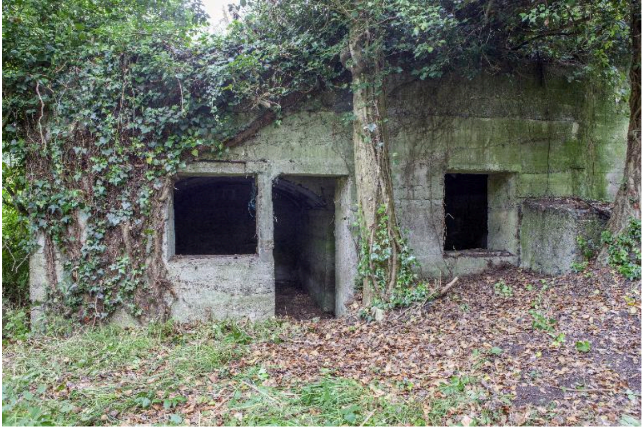
Casemate à personnel
