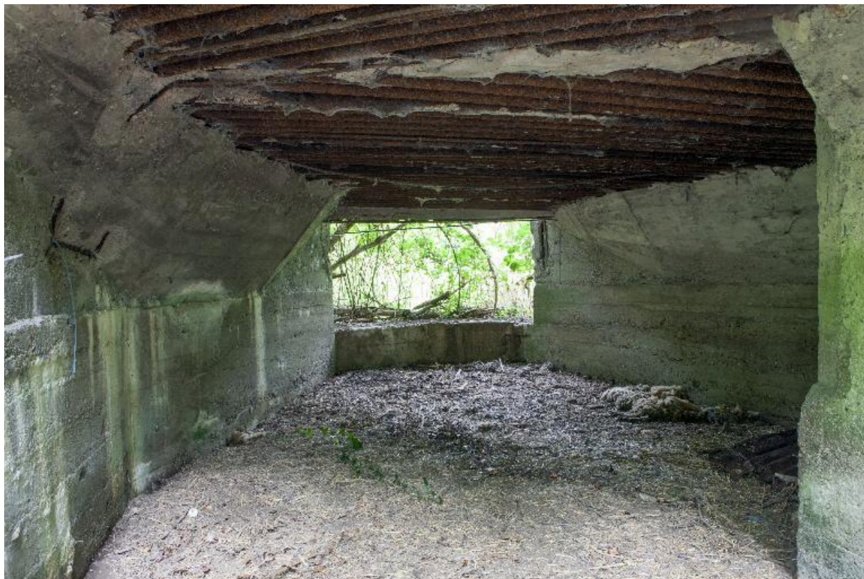
Vue en enfilade de la chambre de tir, vers le nord-ouest
