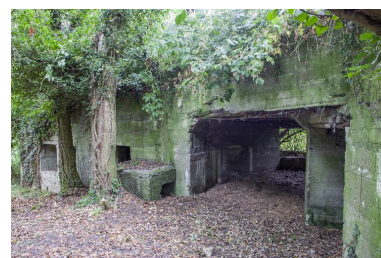
Chambre de tir en enfilade Phot. Pierre Thibaut IVR32_20165901070NUCA
