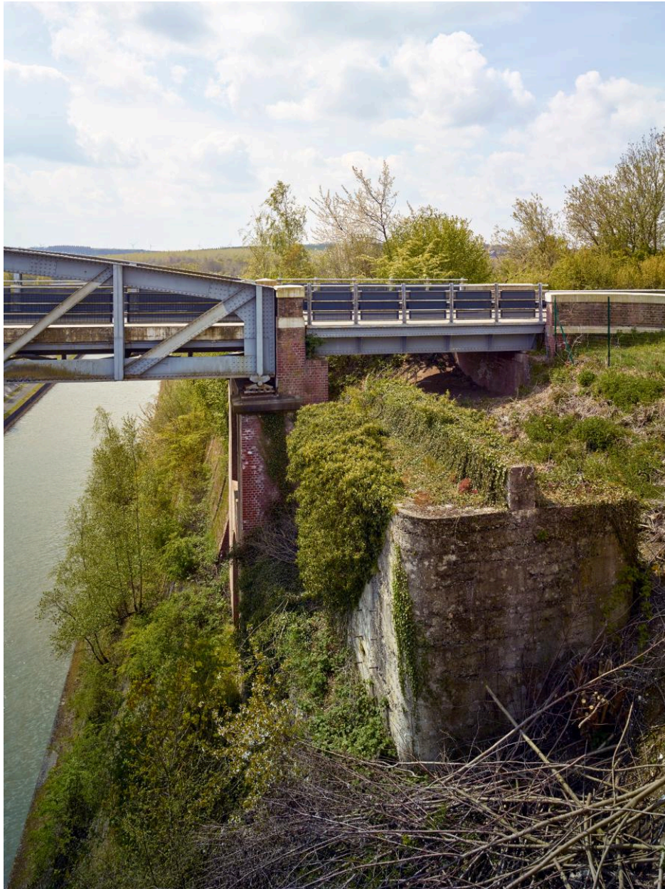
Pont sud (rive ouest). Vestige de la culée du pont provisoire britannique.
