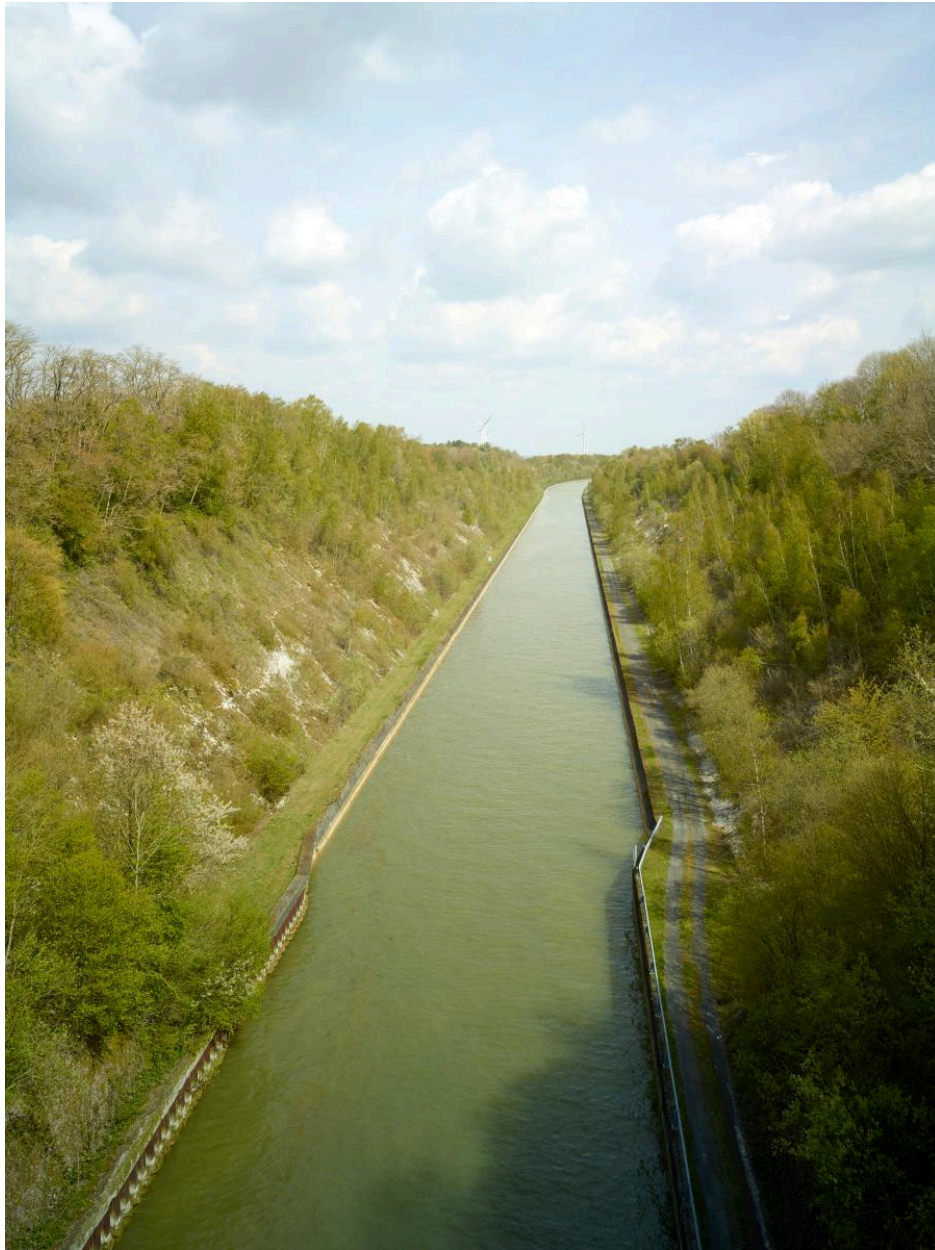
Vue vers le nord depuis le pont routier.
