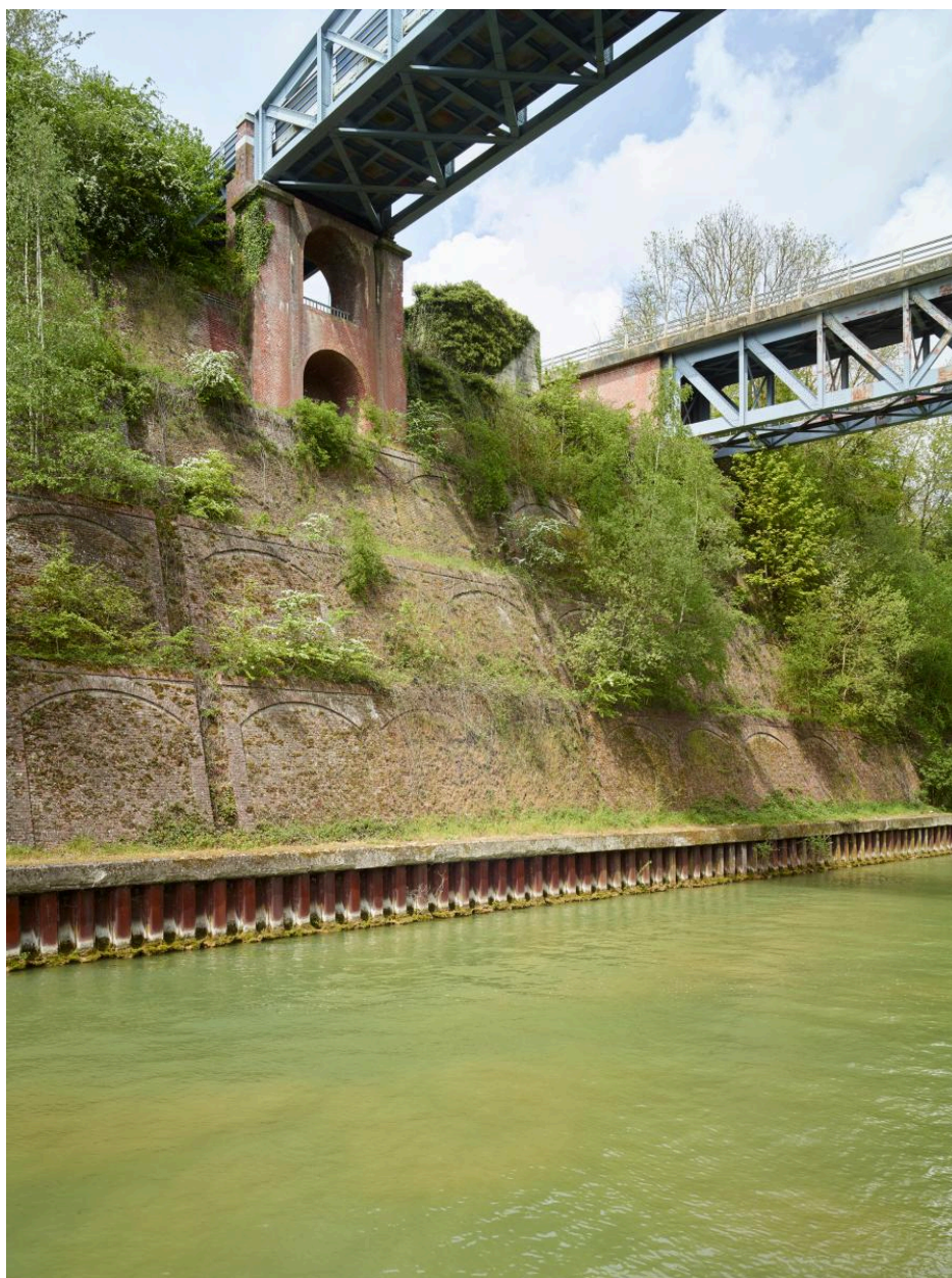
Vue vers les deux ponts métalliques. Aperçu des murs de soutènement en gradins et de la culée du pont sud.
