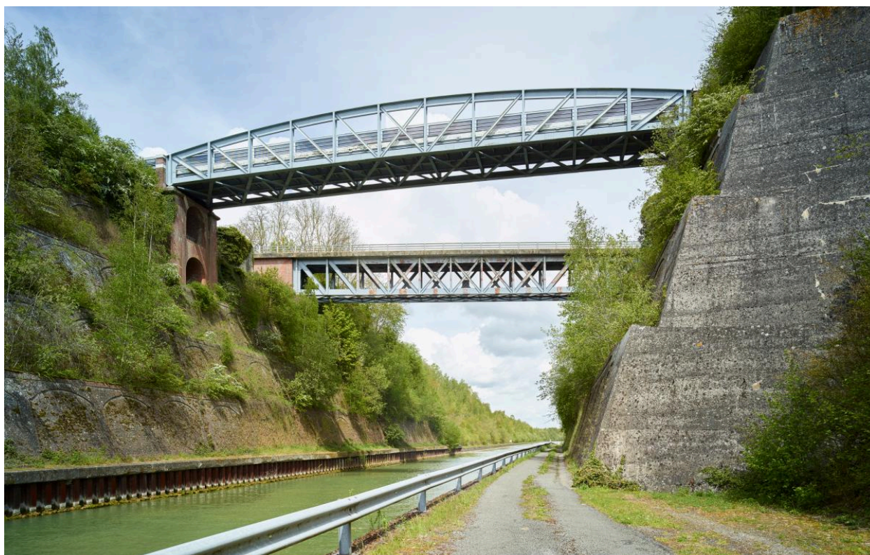
Vue rapprochée depuis le sud vers l'ouvrage. Profil des murs de soutènement en gradins, voie de service.
