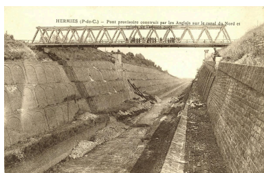
Pont provisoire installé par les troupes du Génie britannique pour rétablir la circulation sur la grande tranchée d'Havrincourt. Carte postale, vers 1918 (?). Repro. Pierre Thibaut IVR32_20226200281NUCAB
