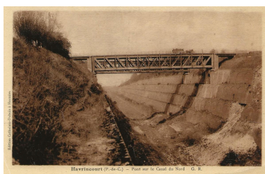
Deux ponts métalliques mis en place sur la grande tranchée d'Havrincourt pour rétablir la circulation après guerre. Les berges restent endommagées. Carte postale, vers 1918-1920 (?). Repro. Pierre Thibaut IVR32_20226200279NUCAB
