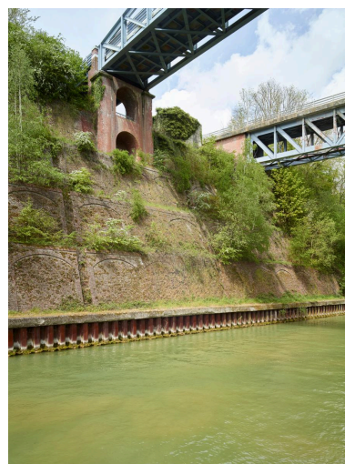
Vue vers les deux ponts métalliques. Aperçu des murs de soutènement en gradins et de la culée du pont sud. Phot. Pierre Thibaut IVR32_20216200755NUC4
