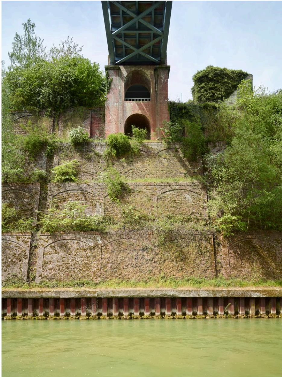
Sou le pont sud (rive ouest). Vue des murs de soutènements en gradins et culée du pont sud.
