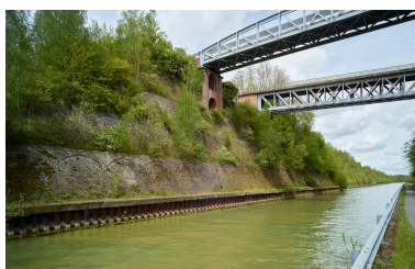
Vue depuis le sud. Murs de soutènement en gradins, deux ponts. Phot. Pierre Thibaut IVR32_20216200802NUC4
