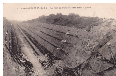
État de la grande tranchée d'Havrincourt après la Première Guerre mondiale. Destruction des ponts et d'une partie des berges maçonnées. Cuvette partiellement comblée. Carte postale, après 1918. Repro. Pierre Thibaut IVR32_20226200278NUCAB
