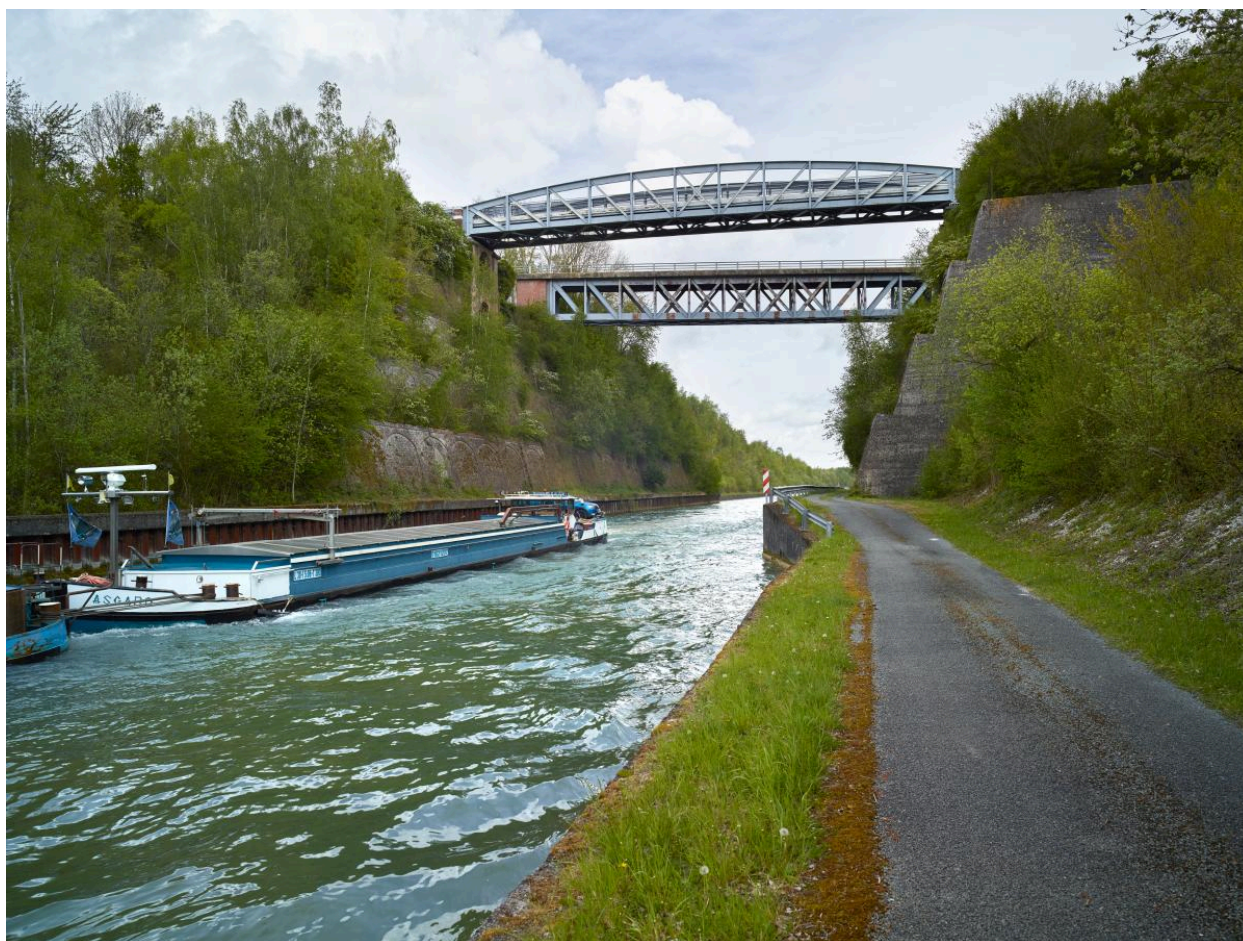
Vue depuis le sud de l'ouvrage.
