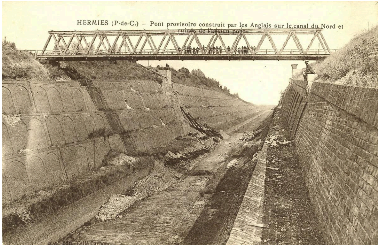
Pont provisoire installé par les troupes du Génie britannique pour rétablir la circulation sur la grande tranchée d'Havrincourt. Carte postale, vers 1918 (?).
