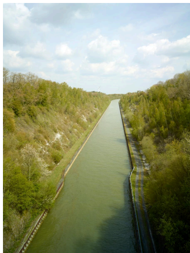
Vue vers le nord depuis le pont routier. Phot. Pierre Thibaut IVR32_20216200739NUC4
