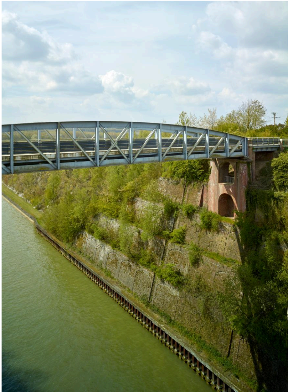
Vue vers le Nord depuis le second pont routier. Murs de soutènements en gradins.
