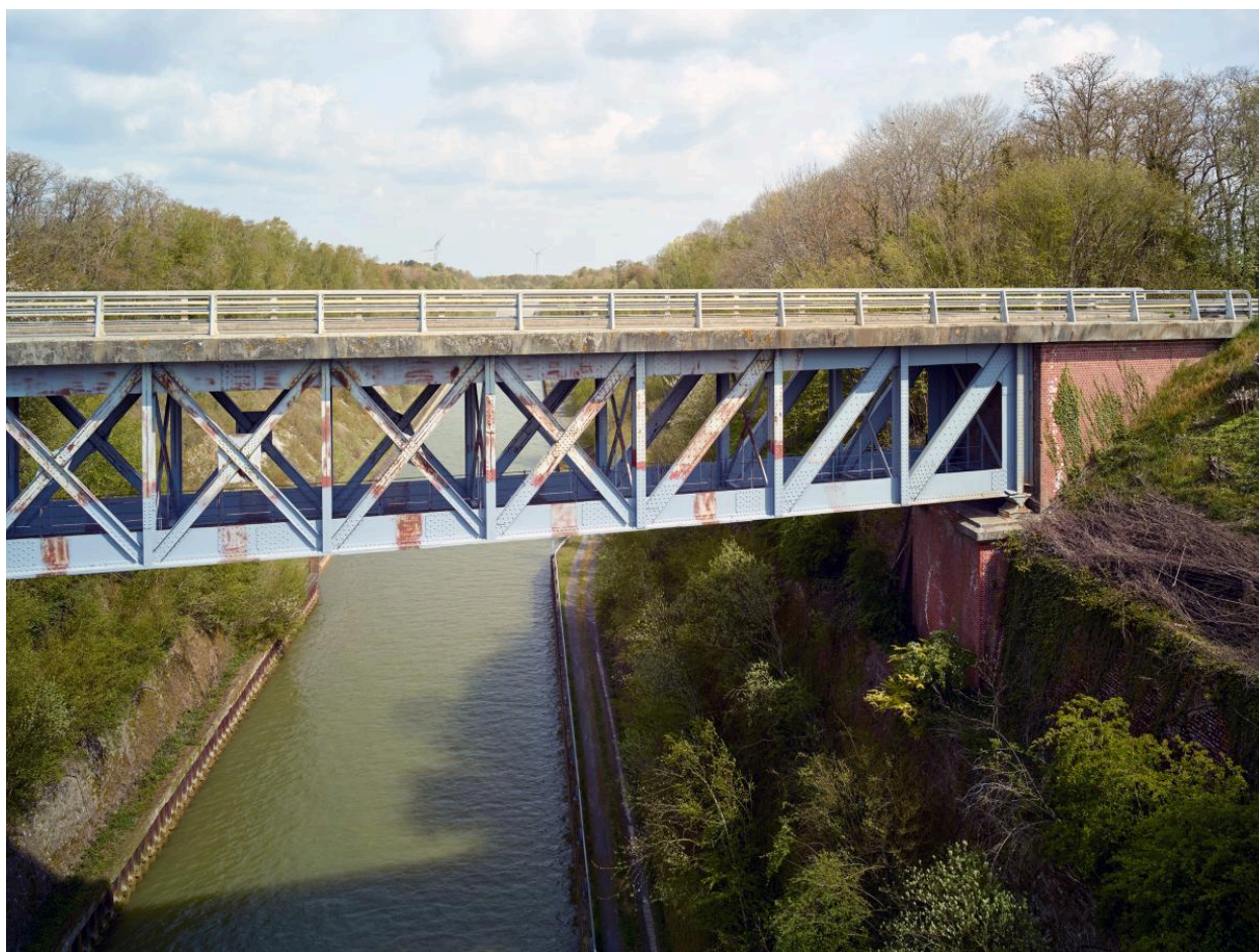
Pont routier nord.
