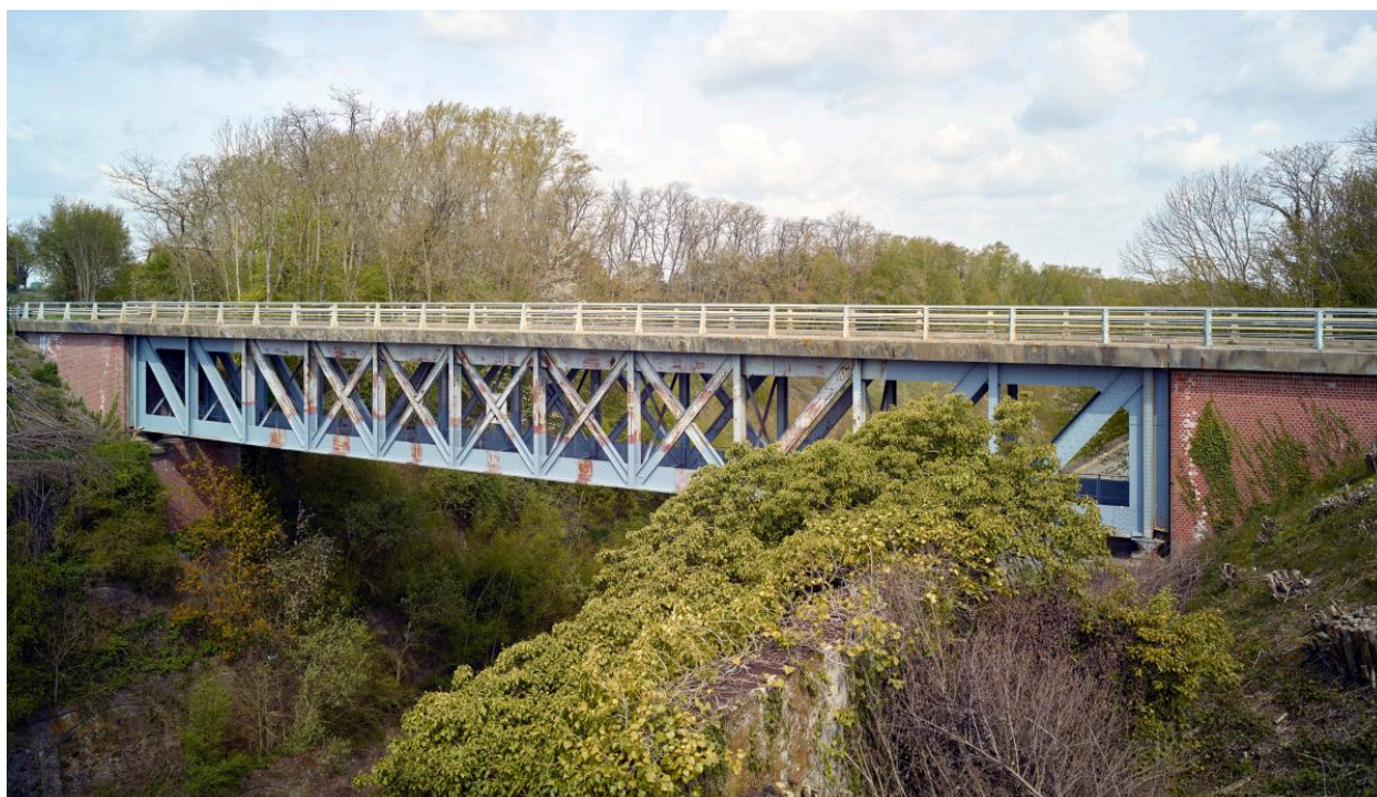
Pont routier nord.
