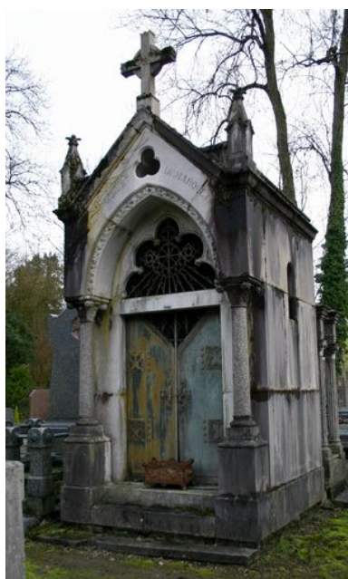
Vue générale du tombeau-chapelle.
