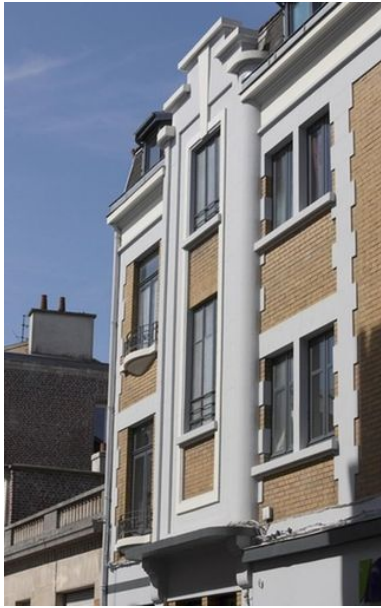
Oriel situé sur la façade rue du Général-Barbot. Phot. Pierre Thibaut IVR31_20086200121NUCA
