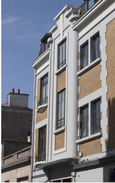
Oriel situé sur la façade rue du Général-Barbot. Phot. Pierre Thibaut IVR31_20086200121NUCA
