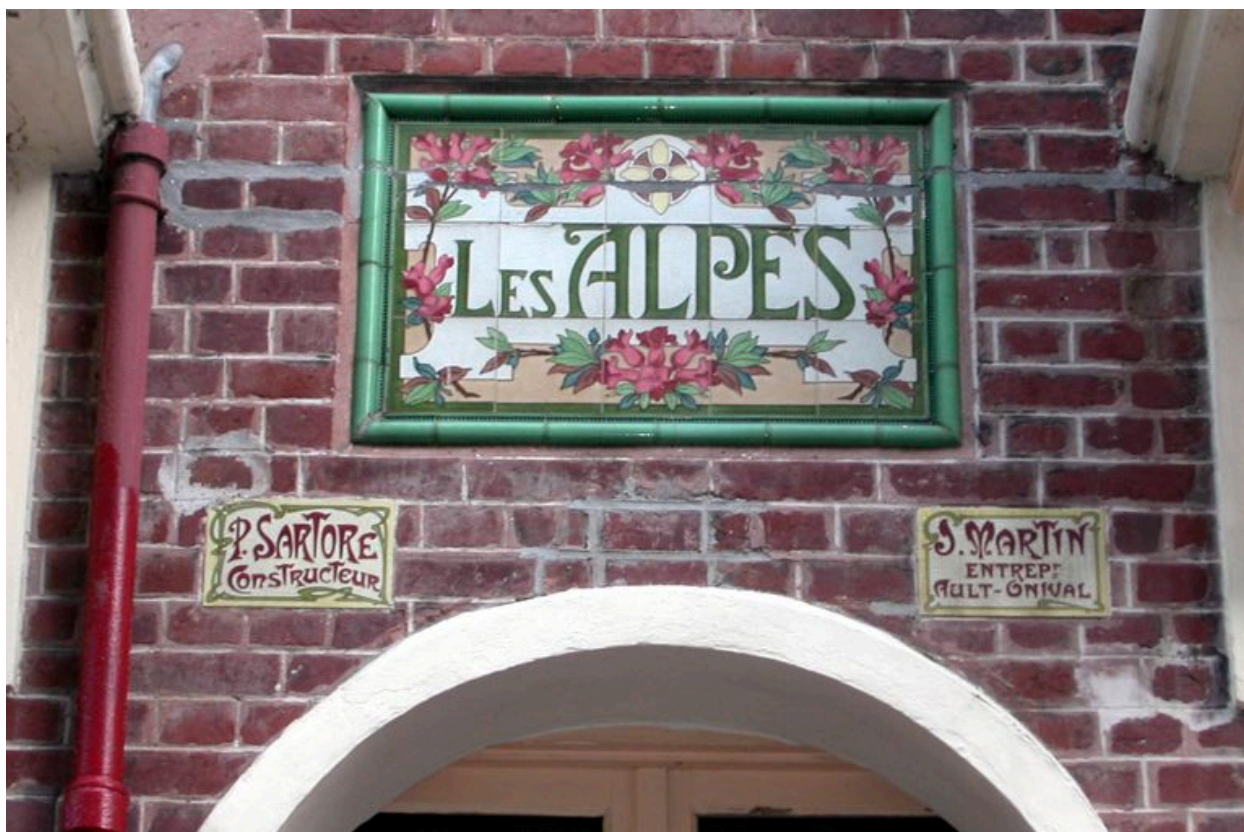
Détail des deux plaques de signature et du panneau de céramique portant appellation du logement dit Les Alpes.
