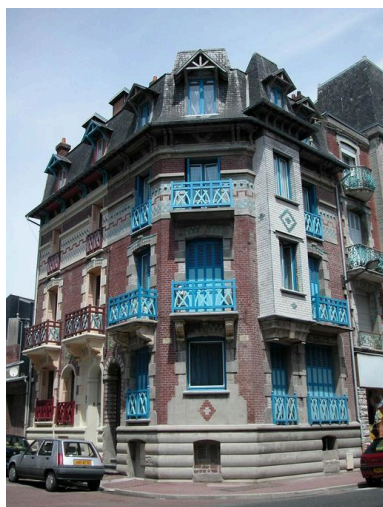
Vue d'ensemble depuis l'avenue du Maréchal-Foch. Phot. Elisabeth Justome IVR22_20038005275NUCA
