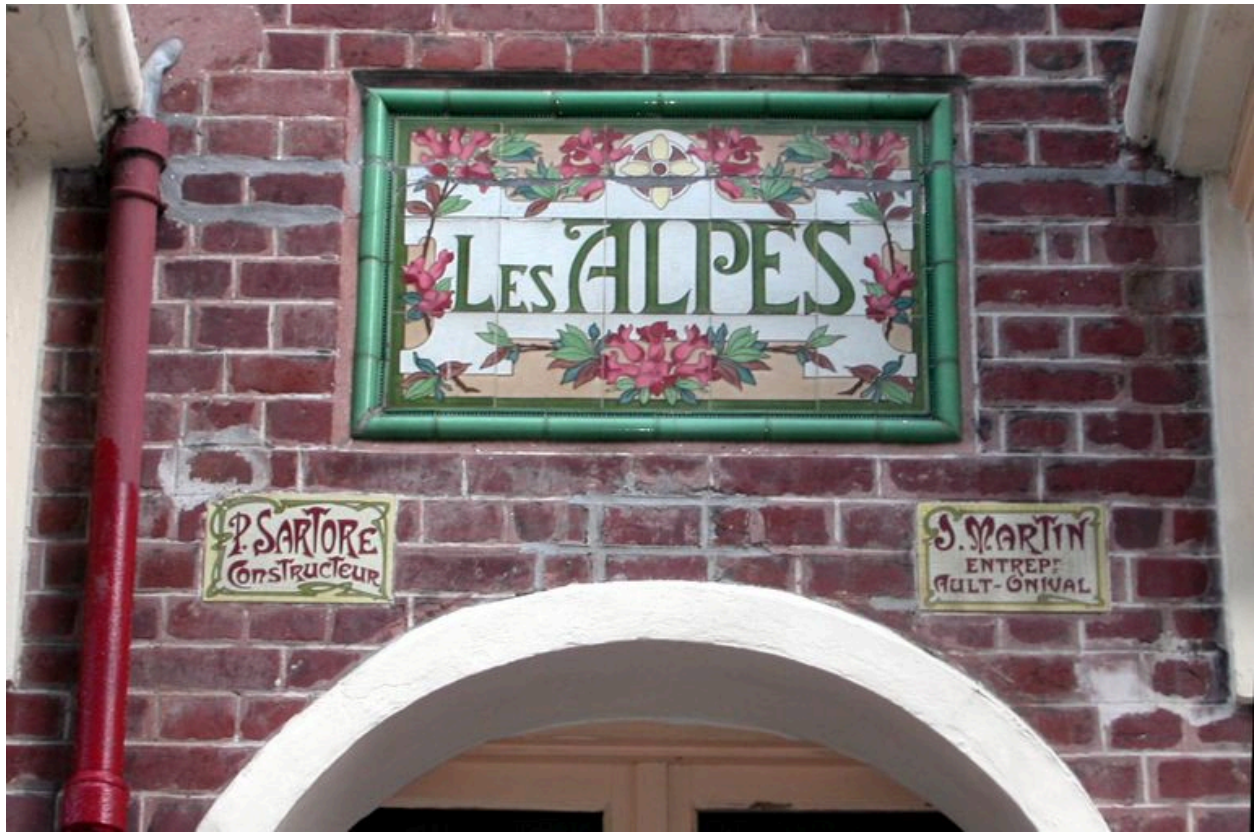
Détail des deux plaques de signature et du panneau de céramique portant appellation du logement dit Les Alpes.
