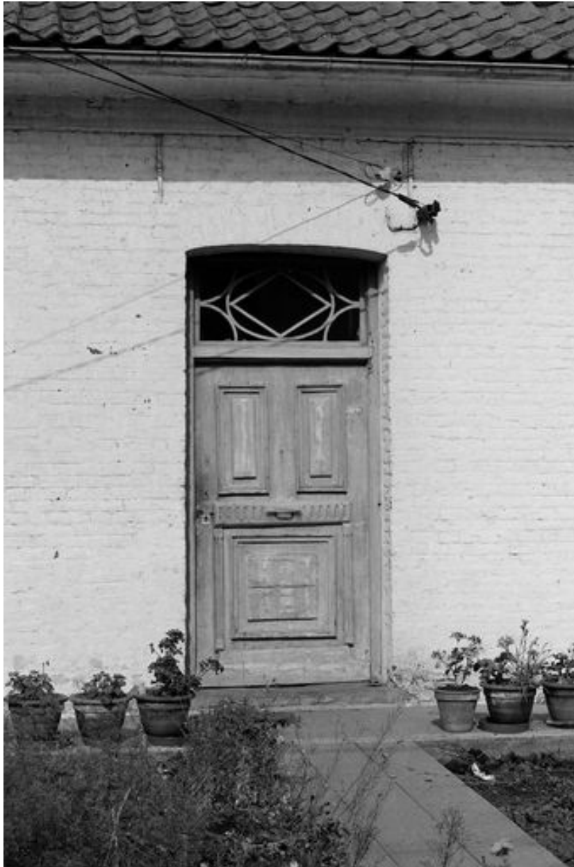
Détail de la porte et de l'imposte.
