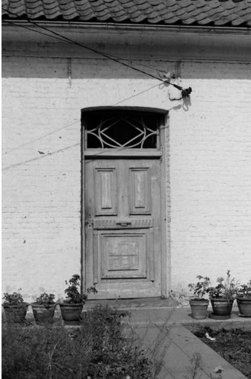
Détail de la porte et de l'imposte.
