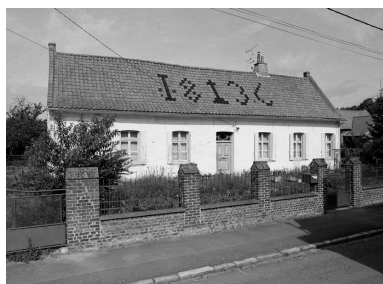
Vue générale. Phot. Philippe Dapvril IVR31_20045900451X
