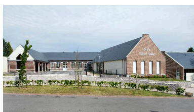
Vue d'ensemble sur rue. Phot. Thierry Lefébure IVR22_20138000434NUC2AQ
