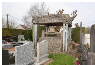
Tombeau d'attente réalisé par Charles Pecqueur durant son mandat de maire, cimetière de Ruitz. Phot. Hubert Bouvet IVR31_20146202727NUC4A
