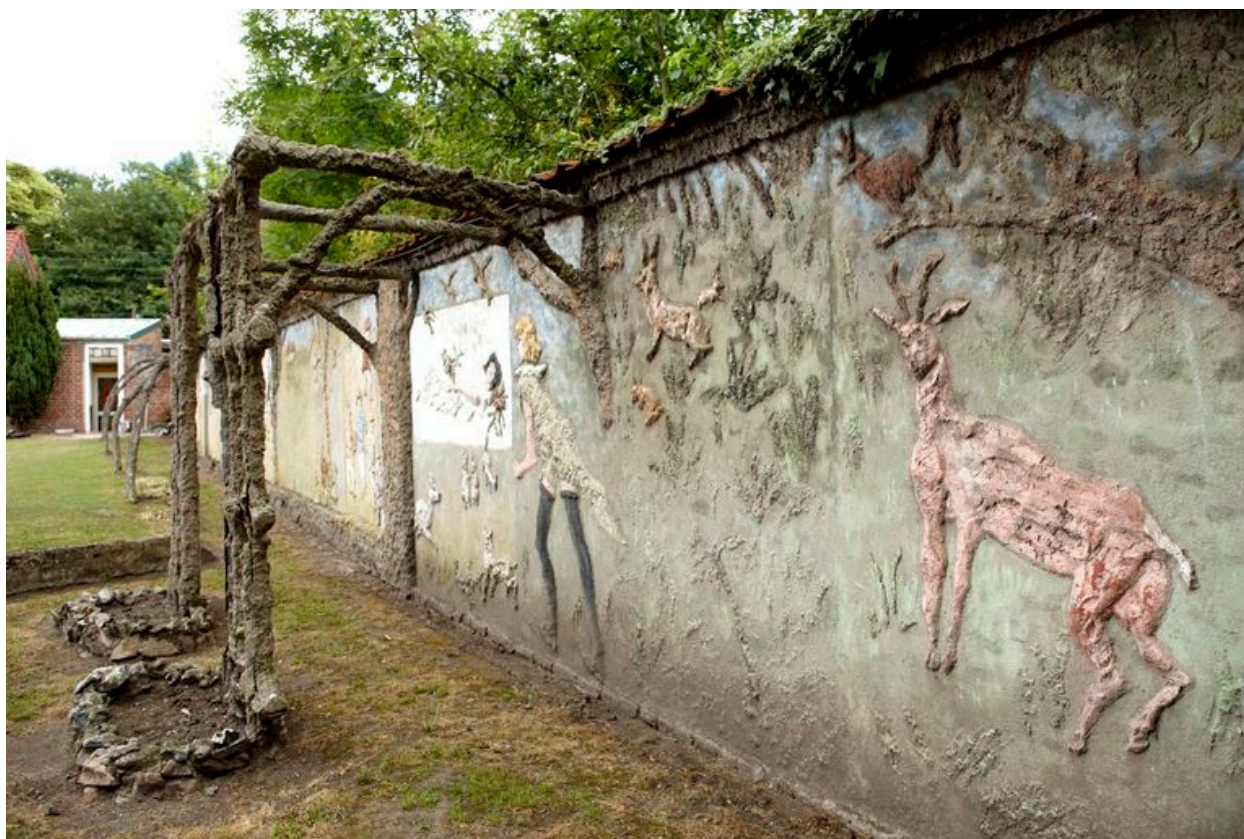
Palissade du jardin, vue partielle.
