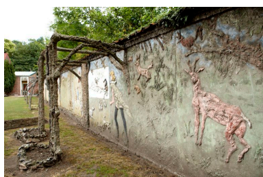
Palissade du jardin, vue partielle. Phot. Hubert Bouvet IVR31_20106201399NUCA
