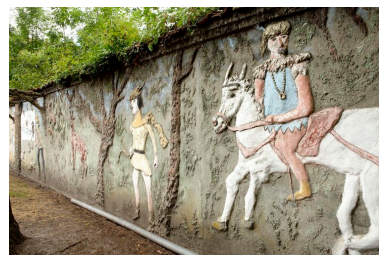
Palissade du jardin, vue partielle. Phot. Hubert Bouvet IVR31_20106201398NUCA
