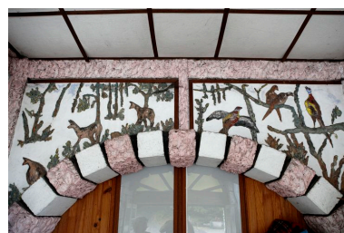
Vue intérieure du garage : voûte et extrados de voûte décorés. Phot. Hubert Bouvet IVR31_20106201436NUCA
