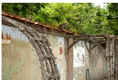
Palissade du jardin, détail. Phot. Hubert Bouvet IVR31_20106201407NUCA
