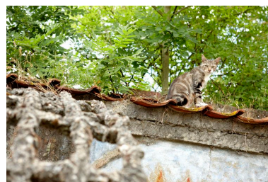
Palissade du jardin, détail. Phot. Hubert Bouvet IVR31_20106201406NUCA
