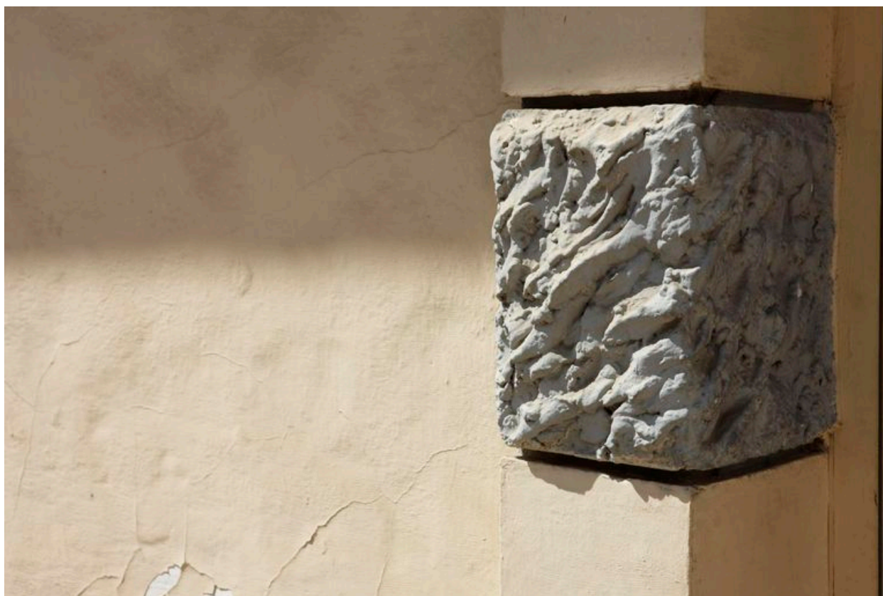
Maison, détail de la maçonnerie.
