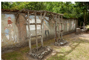
Palissade du jardin, vue partielle. Phot. Hubert Bouvet IVR31_20106201403NUCA
