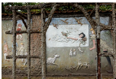
Palissade du jardin, détail. Phot. Hubert Bouvet IVR31_20106201394NUCA
