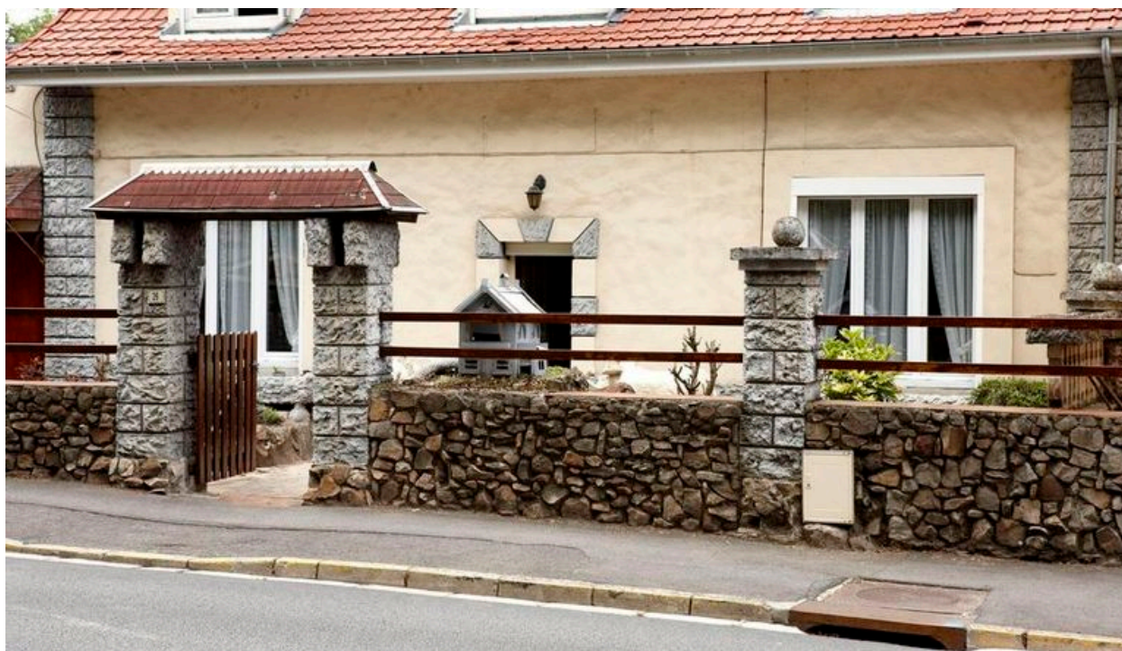
Vue partielle de la façade.
