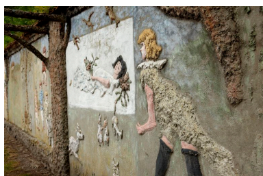
Palissade du jardin, vue partielle. Phot. Hubert Bouvet IVR31_20106201400NUCA
