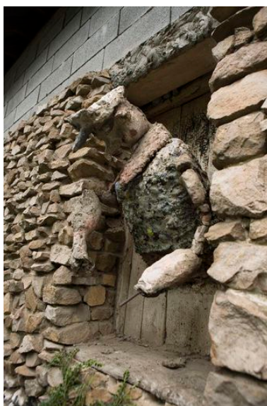
42 rue du Calvaire : Popeye, vue de profil. Phot. Hubert Bouvet IVR31_20106201393NUCA
