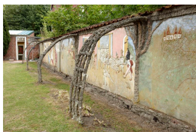
Palissade du jardin, vue partielle. Phot. Hubert Bouvet IVR31_20106201404NUCA
