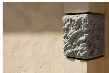
Maison, détail de la maçonnerie. Phot. Hubert Bouvet IVR31_20106201418NUCA
