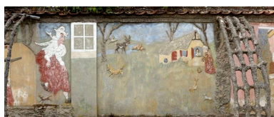
Palissade du jardin, vue partielle. Phot. Hubert Bouvet IVR31_20106201389NUCA
