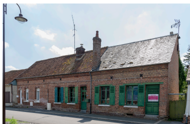
Anciens logements d'ouvriers, n°24-26, rue de l'École, vue prise depuis le nord-est. Phot. Marc Kérignard IVR32_20236000874NUCA
