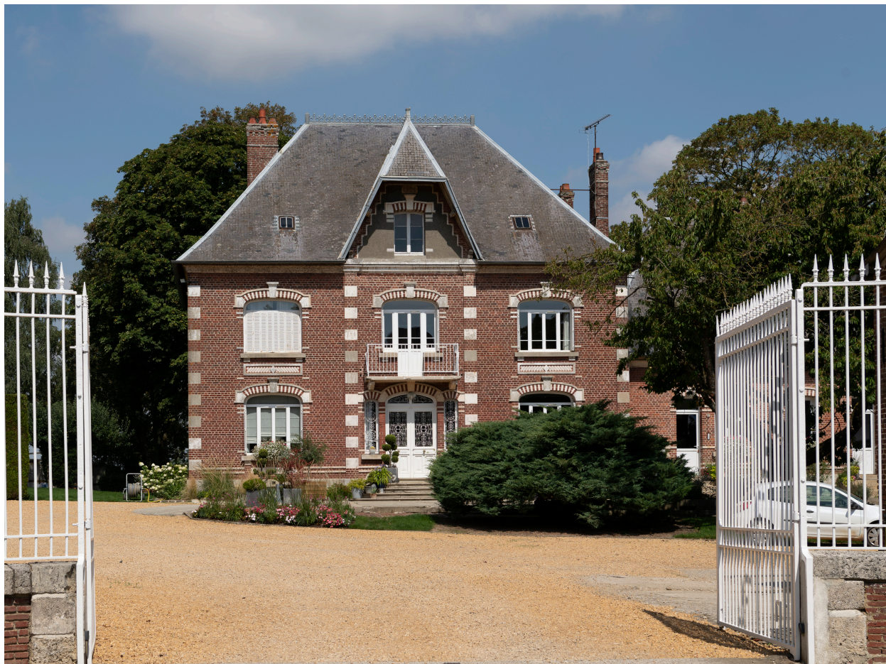
Logis de la ferme dite "de M. Geffroy", n°67 de la rue Roland-Mariage, vue prise depuis le sud.
