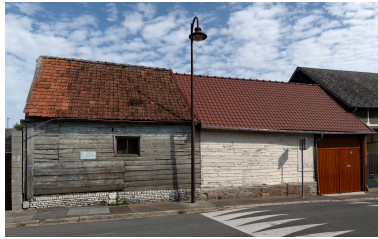
Deux granges sur rue, n °23-25 de la rue Roland- Mariage, vue prise depuis le sud. Phot. Marc Kérignard IVR32_20236000890NUCA
