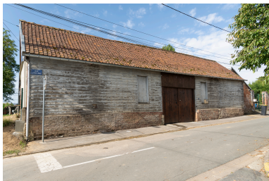
Grange sur rue avec portes à engranger, n°1 de la rue du Petit Paris, vue prise depuis le nord. Phot. Marc Kérignard IVR32_20236000892NUCA
