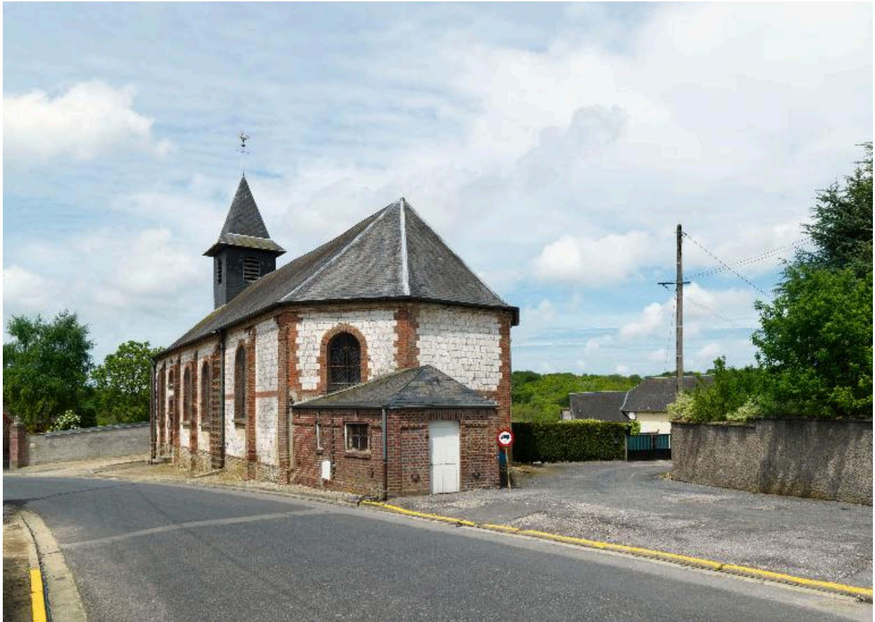
Vue générale de l'église depuis la rue François Mitterrand
