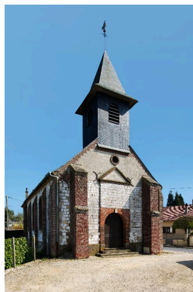
Vue générale depuis nord-ouest Phot. Thierry Lefébure IVR22_20138000263NUC2A
