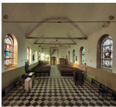
Vue de la nef depuis le chœur. Phot. Thierry Lefébure IVR22_20158001238NUC2A
