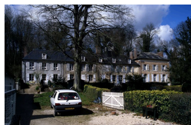
Vue générale. Phot. Marie-Laure Monnehay-Vulliet IVR22_20068000168XA
