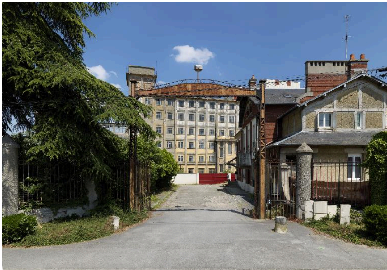
Entrée de la minoterie.
