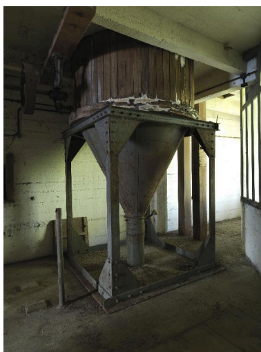
Silo et dévidoir de minoterie. Phot. Thierry Lefébure IVR22_20158000278NUC2A
