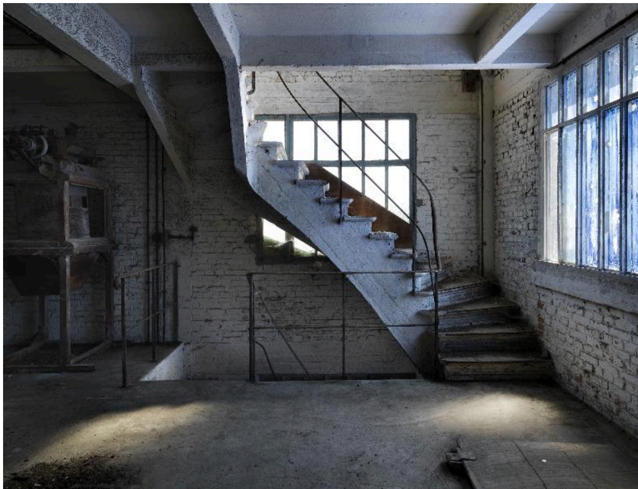
Escalier en béton armé du 2e étage, vue de face.
