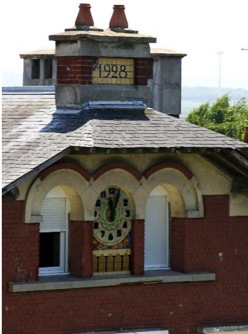
Détail de la partie centrale des bureaux et de la cheminée portant la date de 1928.
