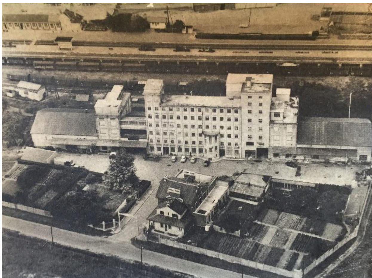
Vue aérienne de l'usine vers 1960. (Coll. part.).
