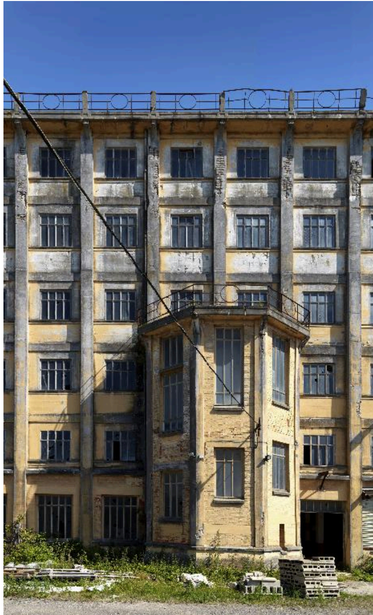
Détail de l'avant-corps semi-hexagonal de la minoterie.
