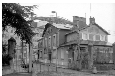
Les bureaux, vue d'ensemble sud-ouest en 1990. Phot. Francis Dubuc IVR22_19908001373Z
