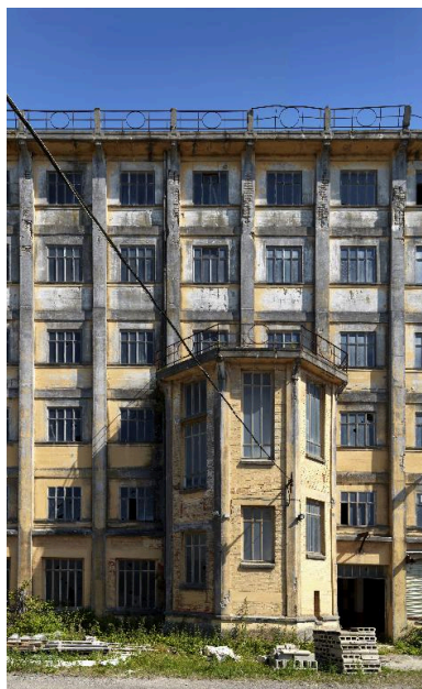
Détail de l'avant-corps semi- hexagonal de la minoterie. Phot. Thierry Lefébure IVR22_20158000265NUC2A
