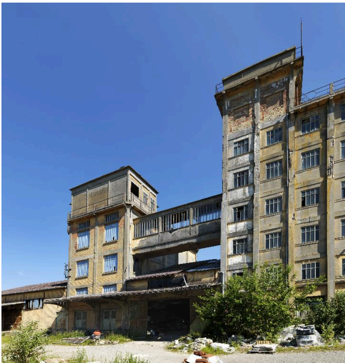
Vue partielle de la façade sud de la minoterie et de la passerelle couverte.
