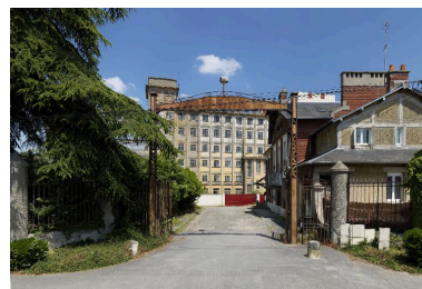
Entrée de la minoterie. Phot. Thierry Lefébure IVR22_20158000261NUC2A
