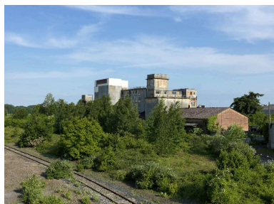
Vue d'ensemble nord de la minoterie et de son embranchement ferroviaire. Phot. Thierry Lefébure IVR22_20158000286NUC2A
