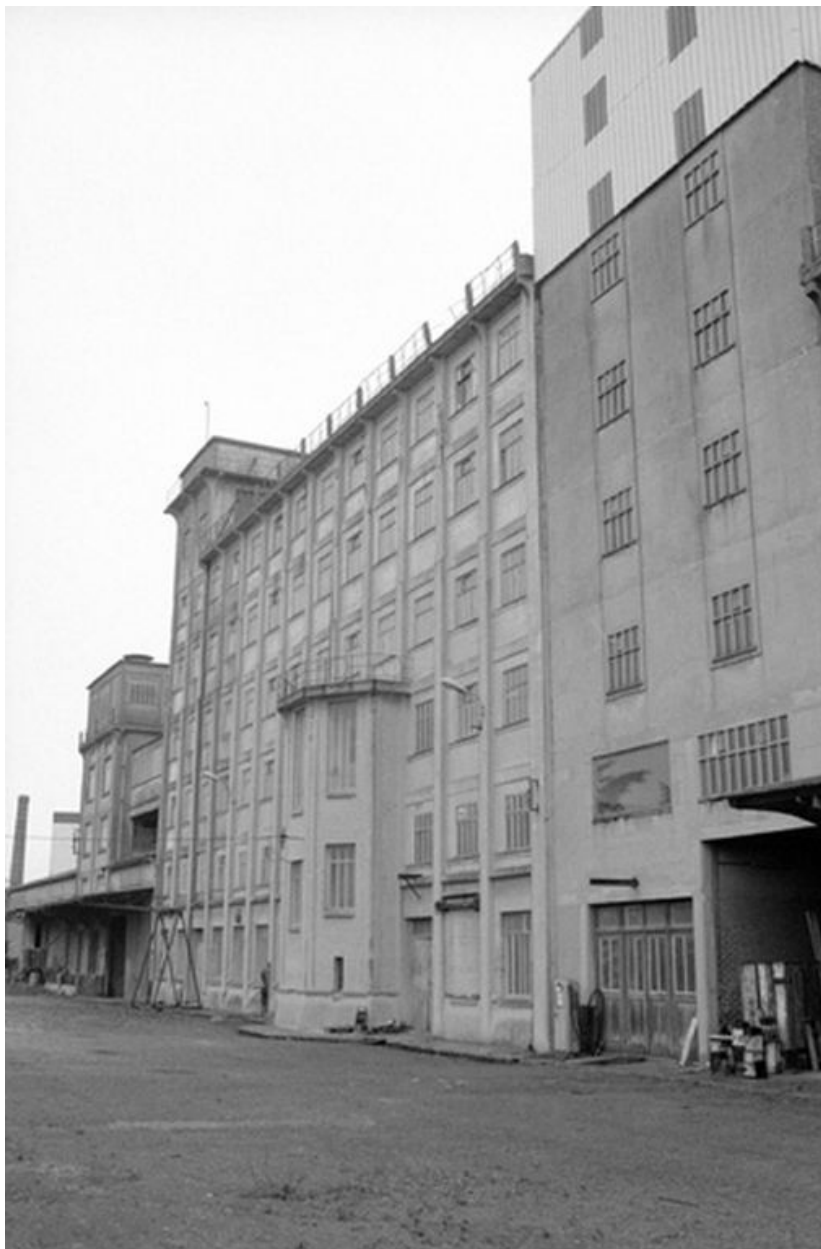
Vue d'ensemble sud-est de la minoterie en 1990.
