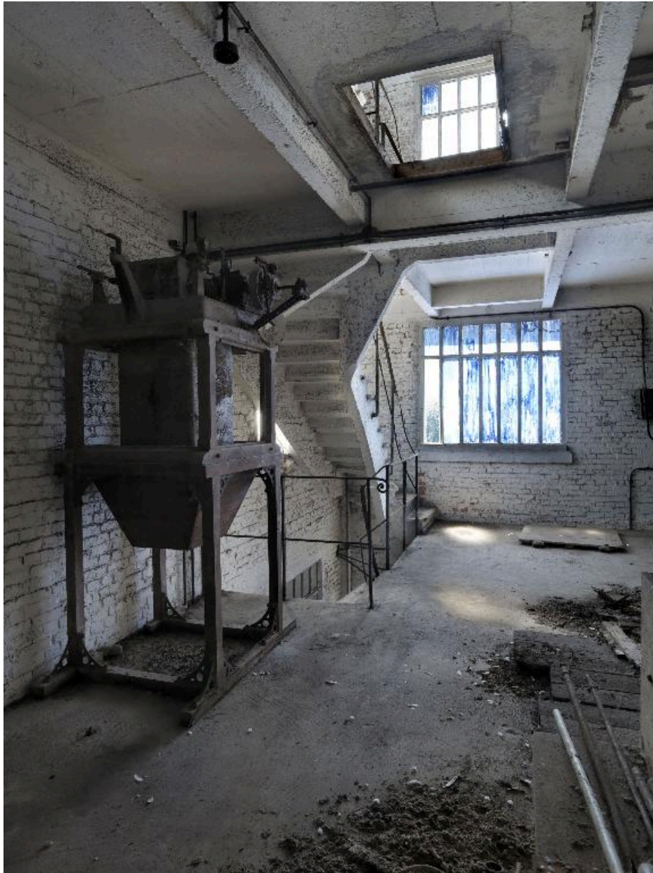
Escalier en béton armé du 2e étage, vue de trois-quarts.
