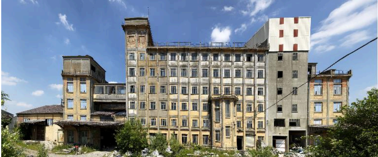
Façade sud de la minoterie.
