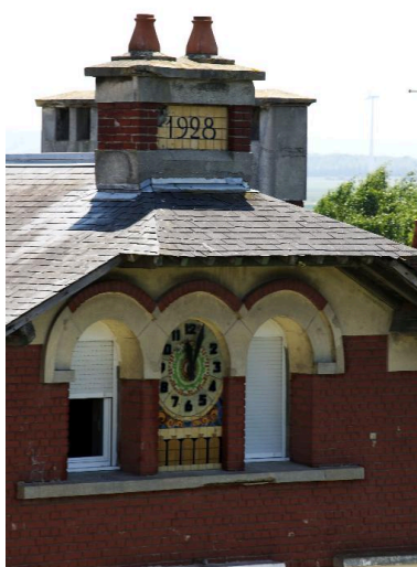
Détail de la partie centrale des bureaux et de la cheminée portant la date de 1928. Phot. Thierry Lefébure IVR22_20158000266NUC2A
