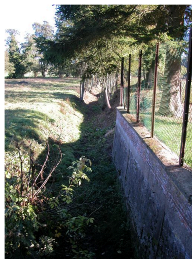
Bief de décharge asséché à l'est du moulin. Phot. Bertrand Fournier IVR22_20036000458NUCA
