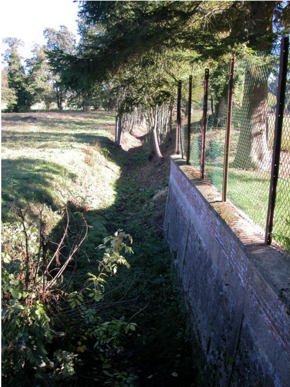
Bief de décharge asséché à l'est du moulin.
