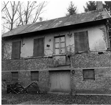
Façade sur cour du moulin. Phot. Thierry Lefébure IVR22_20026001348X
