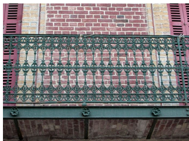
Détail d'un garde-corps en fonderie. Phot. Elisabeth Justome IVR22_20058003490NUCA
