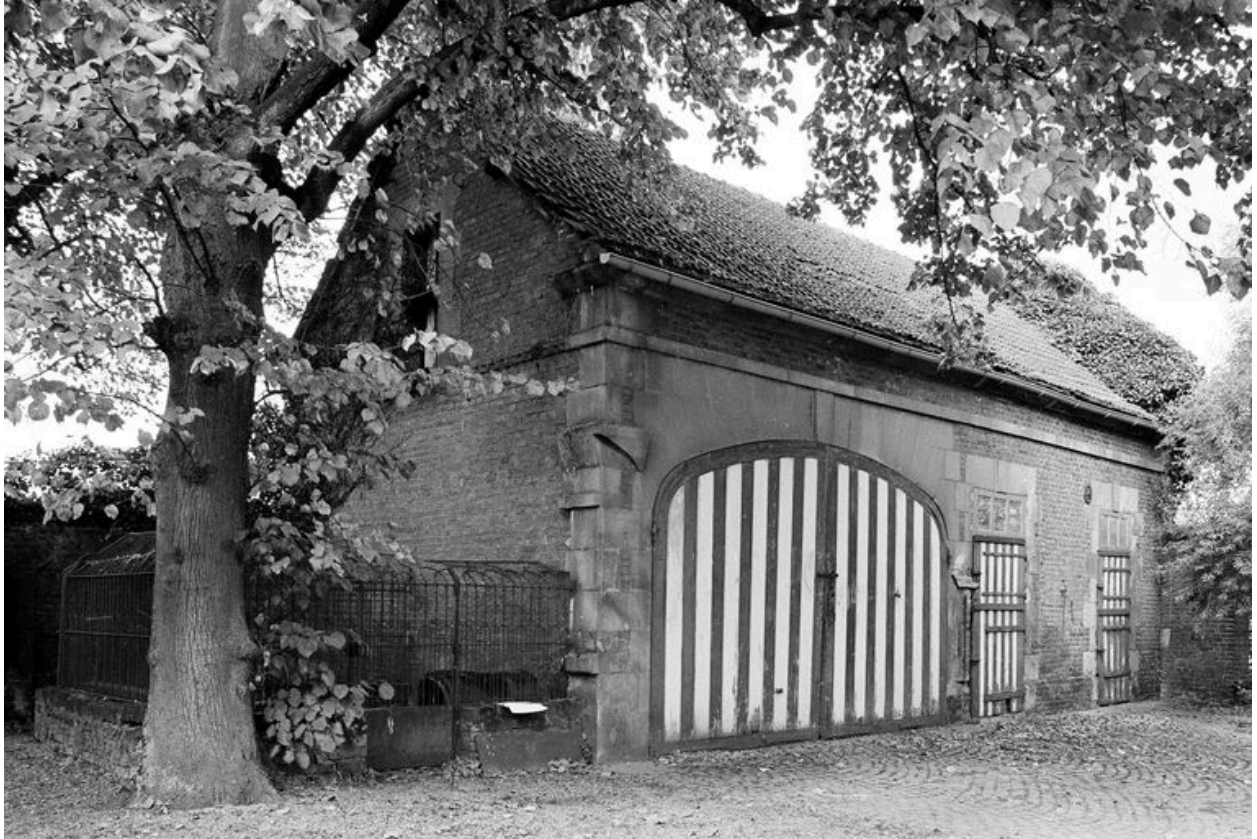
Dépendances du logement patronal.
