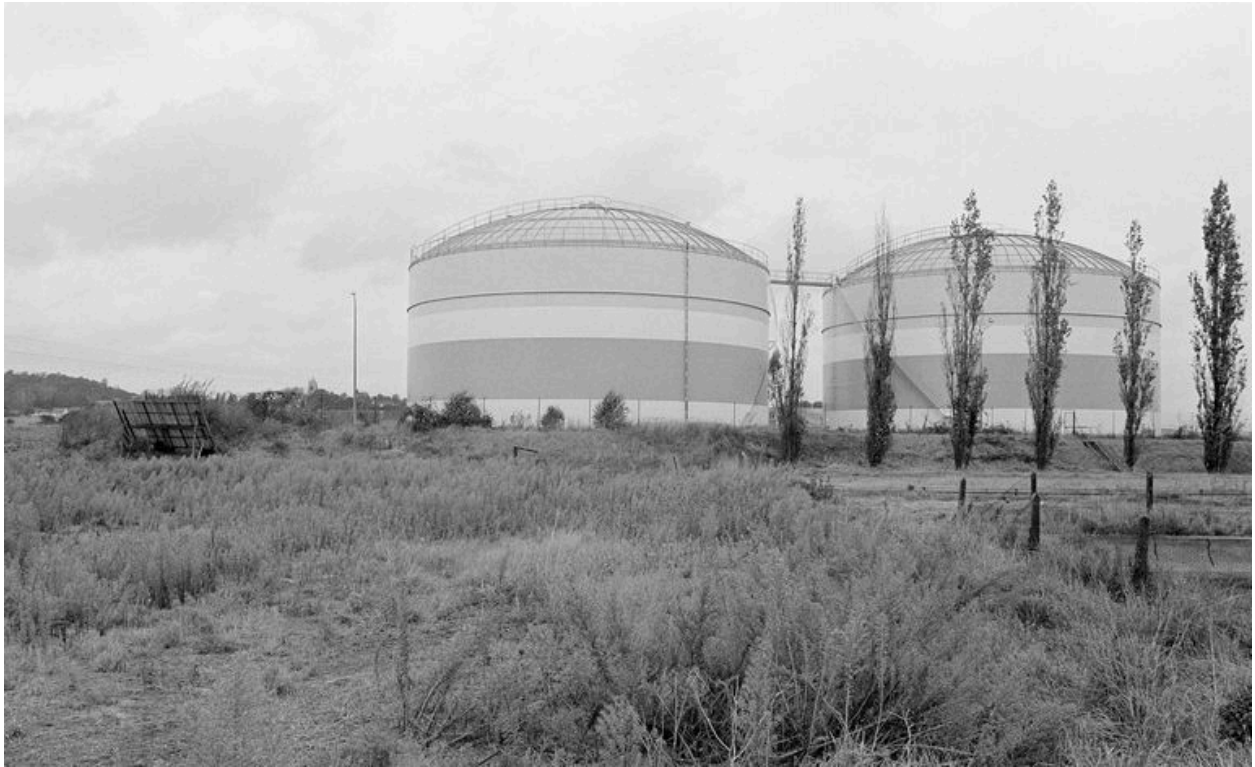
Les silos, vue générale.
