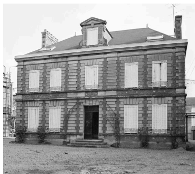
Logement patronal : élévation antérieure. Phot. Benoît Dufournier IVR22_19936002277Z
