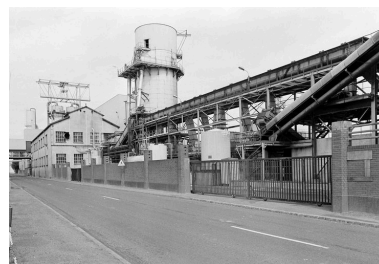
Vue générale de l'usine, flanc est. Phot. Benoît Dufournier IVR22_19936002300Z
