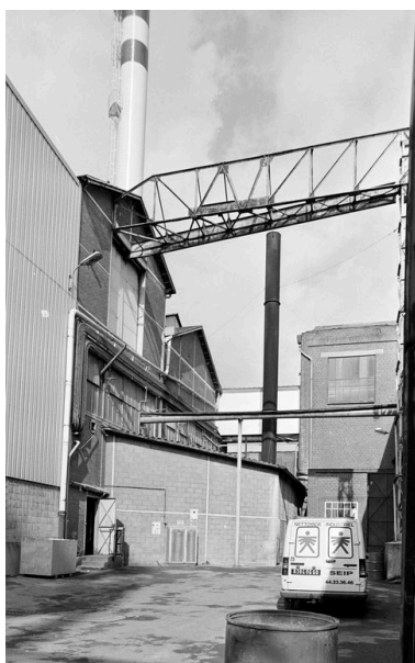
Chaufferie. Phot. Benoît Dufournier IVR22_19936002287Z
