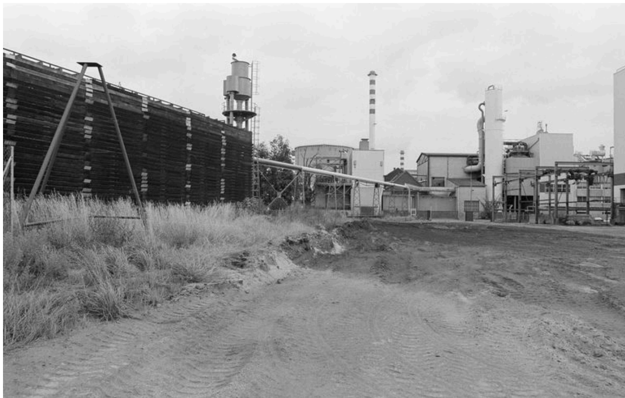
Vue générale, flanc ouest.
