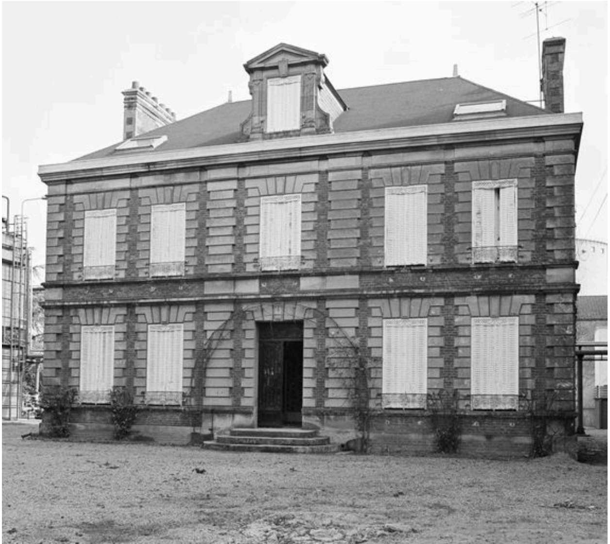
Logement patronal : élévation antérieure.
