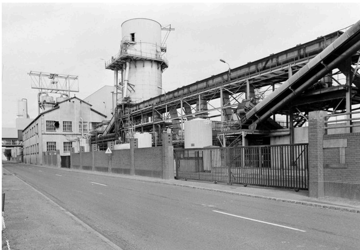
Vue générale de l'usine, flanc est.
