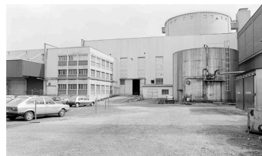
Bureaux et atelier de fabrication. Phot. Benoît Dufournier IVR22_19936002280Z
