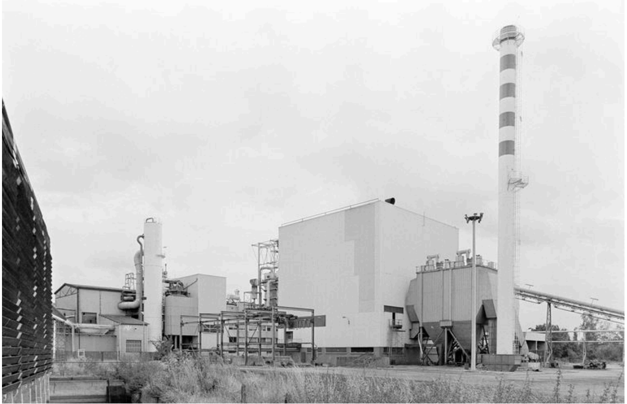
Vue générale de l'usine, flanc ouest.
