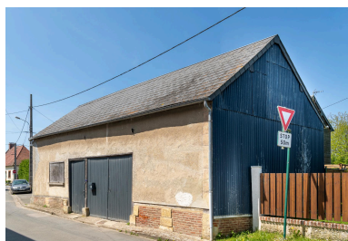
Ancienne maison de serger (?), n°3 rue du Frêne, vue prise depuis le sud. Phot. Marc Kérignard IVR32_20236000558NUCA
