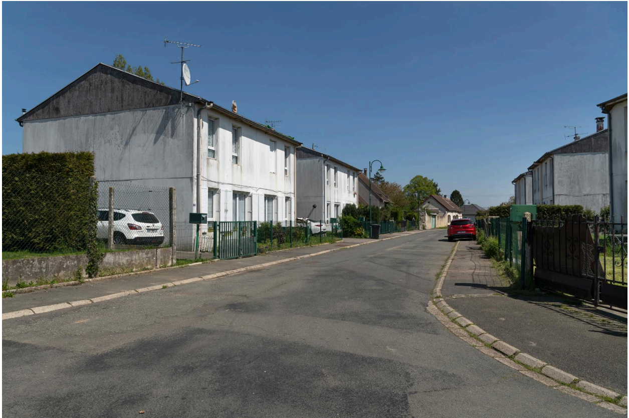
Lotissement de la Petite rue du Frêne, vue prise depuis le sud.
