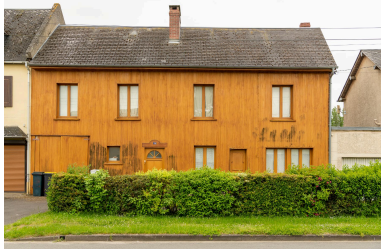
Logis sur rue (ancien commerce ?) essenté de clins, n°12 rue de la Voierie, vue prise depuis le nord. Phot. Marc Kérignard IVR32_20236000747NUCA
