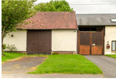
Ancienne grange sur rue avec tuiles pannes, n°26 rue de la Voierie, vue prise depuis le nord. Phot. Marc Kérignard IVR32_20236000748NUCA
