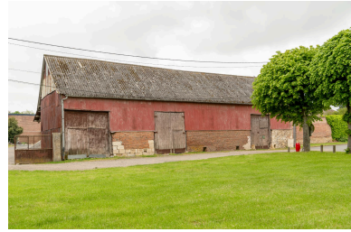
Grange, n°1 rue de la Voierie, vue prise depuis l'est. Phot. Marc Kérignard IVR32_20236000750NUCA
