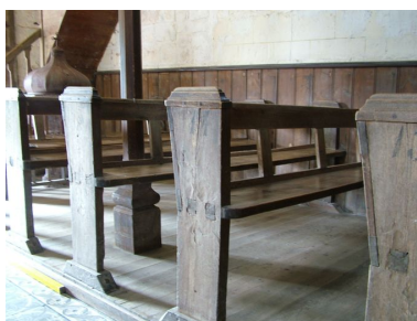
Vue partielle des bancs de fidèles, rangée nord, 1ère moitié du 19e siècle. Phot. Frédéric Fournis IVR22_20098005334NUCA
