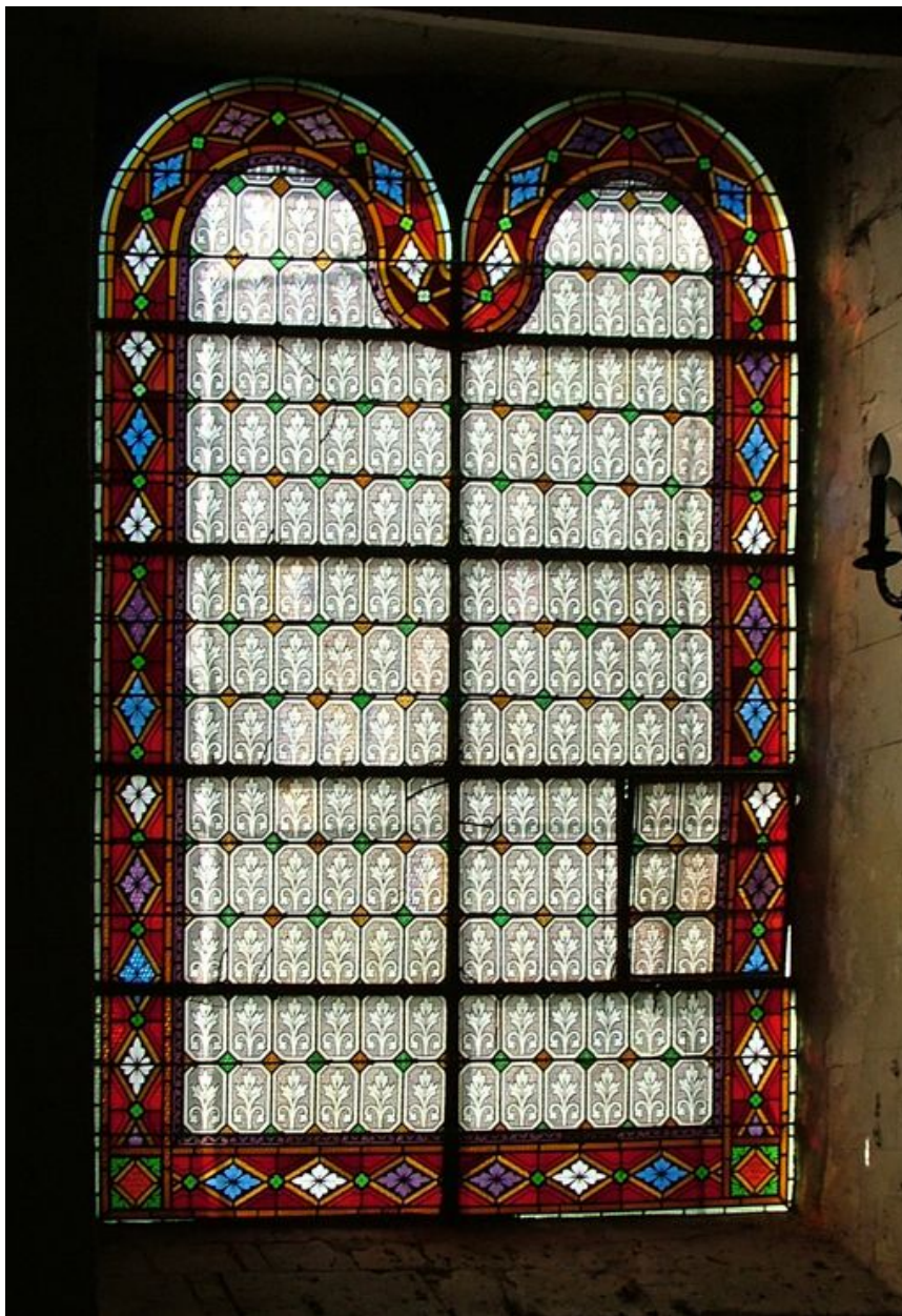
Verrière décorative du bras sud transept (baie 4), signée et datée : MM/BAZIN &LATTEUX/1875/MESNIL/ST FIRMIN/OISE.
