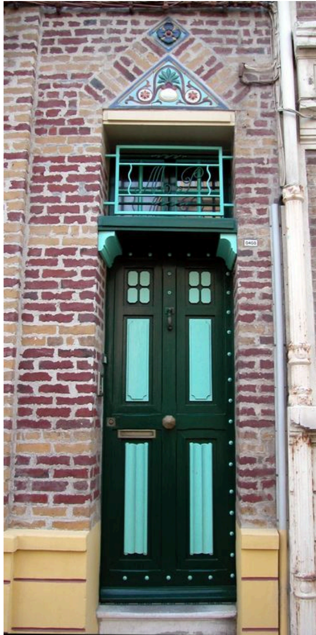
Détail de l'entrée du logement de droite, Yvonne.
