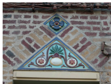
Détail du décor placé au-dessus de la porte d'entrée, logement dit Yvonne. Phot. Elisabeth Justome IVR22_20058003173NUCA
