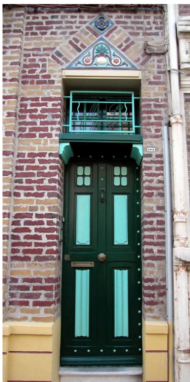
Détail de l'entrée du logement de droite, Yvonne. Phot. Elisabeth Justome IVR22_20058003172NUCA
