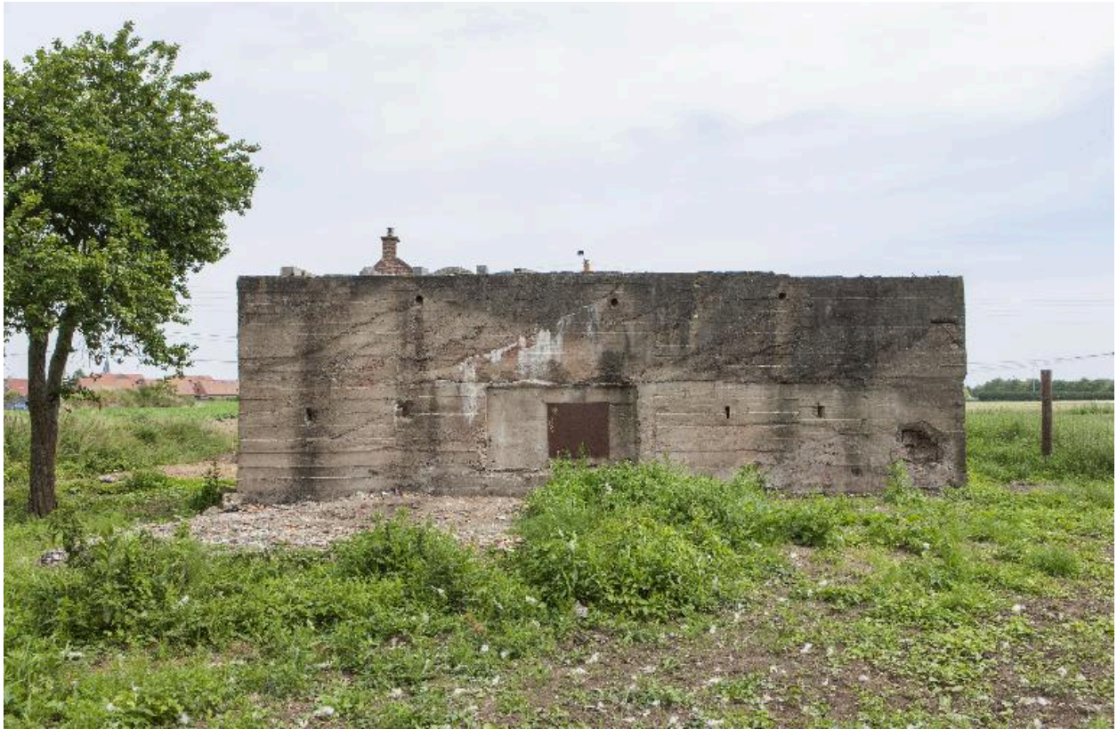
Elévation sud-ouest. L'embrasure de tir, aujourd'hui occultée, est encadrée de créneaux de fusillade.
