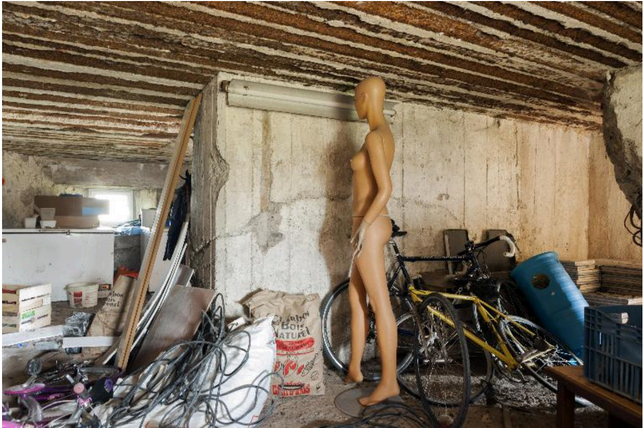
Vue intérieure, vers nord-ouest.
