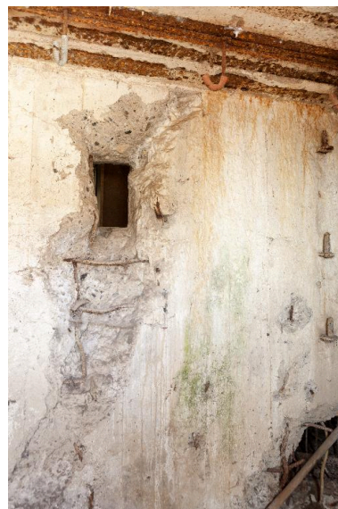
Créneau de fusillade de l'entrée en chicane Phot. Jean-Marc Ramette IVR31_20145905588NUCA
