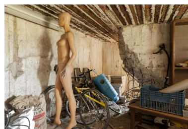
Entrée en chicane, vue vers l'extérieur Phot. Jean-Marc Ramette IVR31_20145905584NUCA
