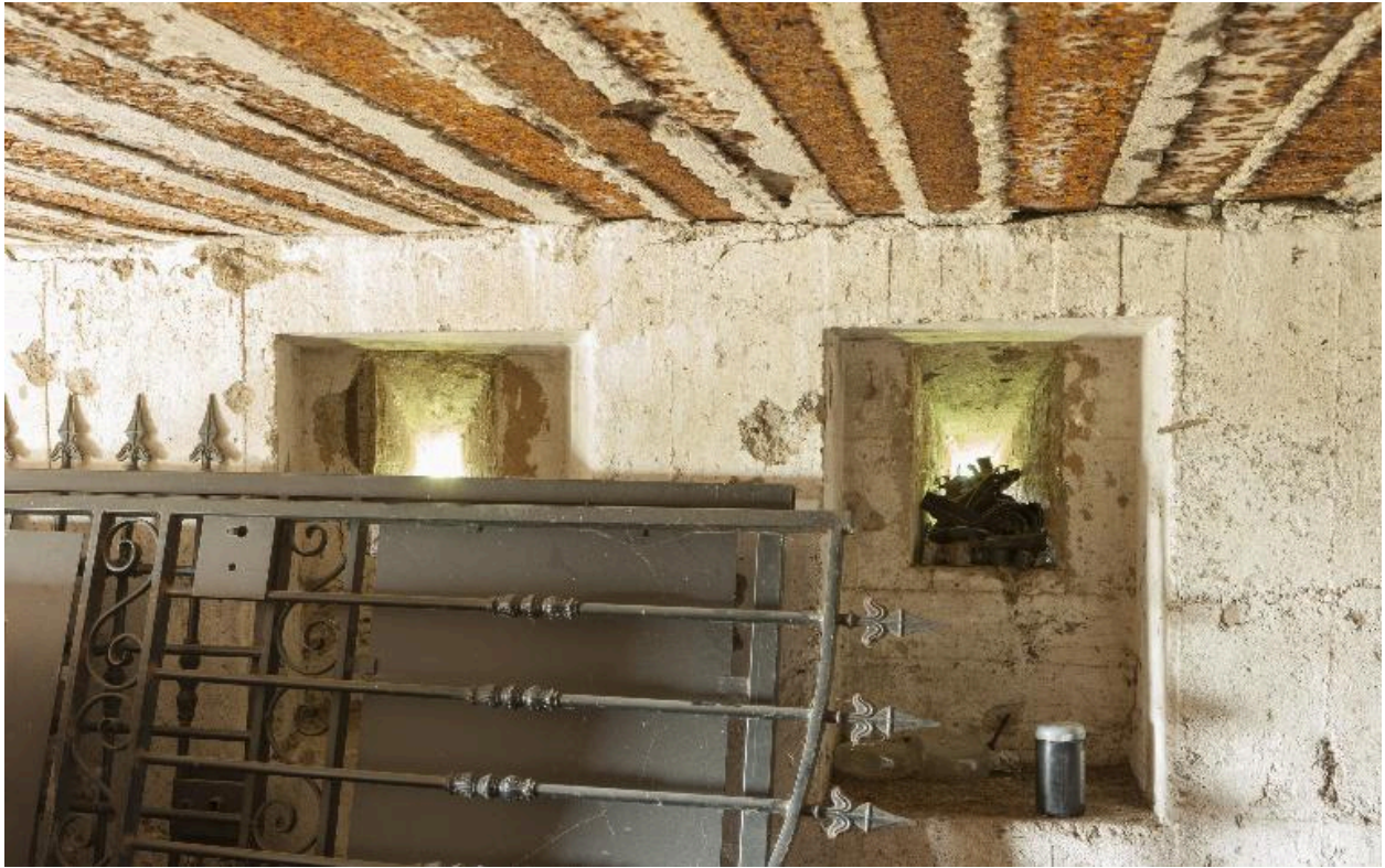
Vue intérieure de deux créneaux de fusillade situés dans l'élévation sud-ouest
