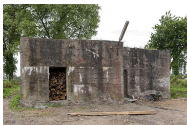
Elévation nord-est Phot. Jean-Marc Ramette IVR31_20145905578NUCA
