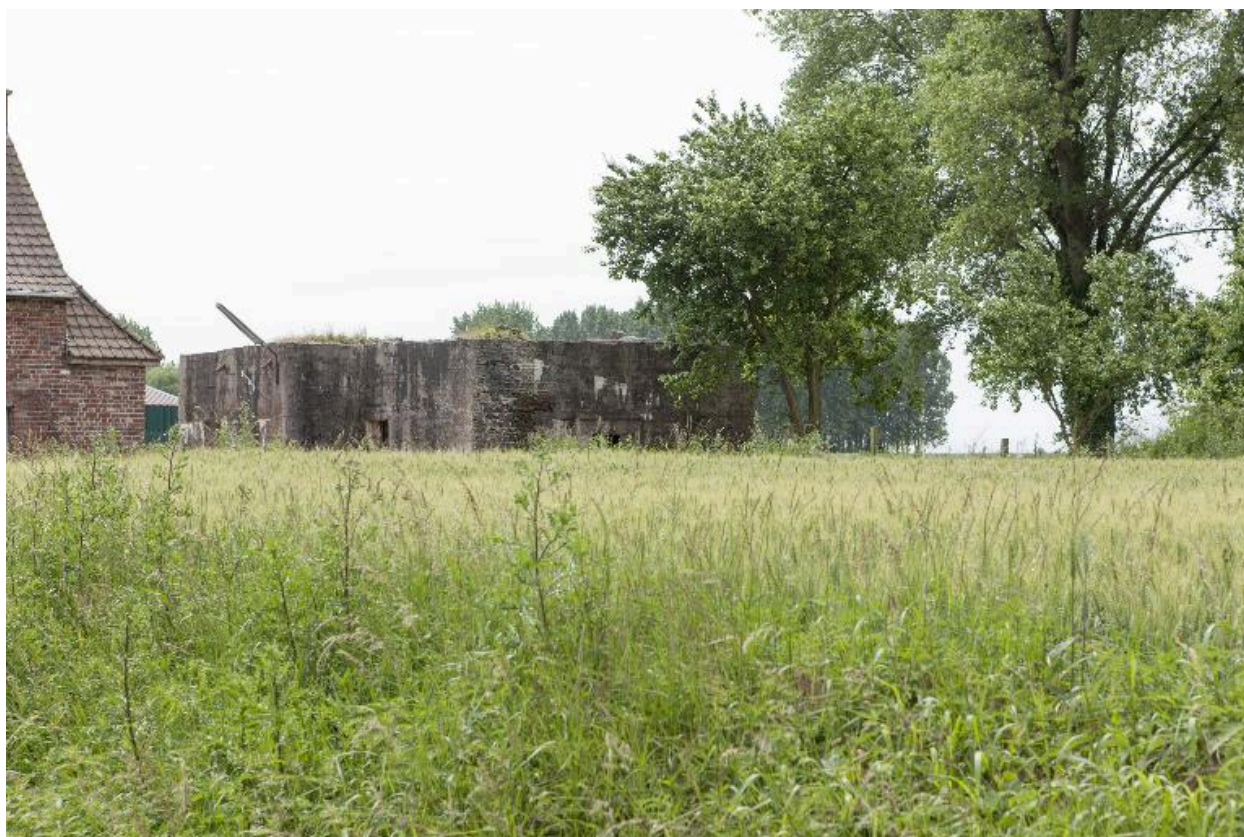
Vue de la casemate depuis la rue Pierre Sémard
