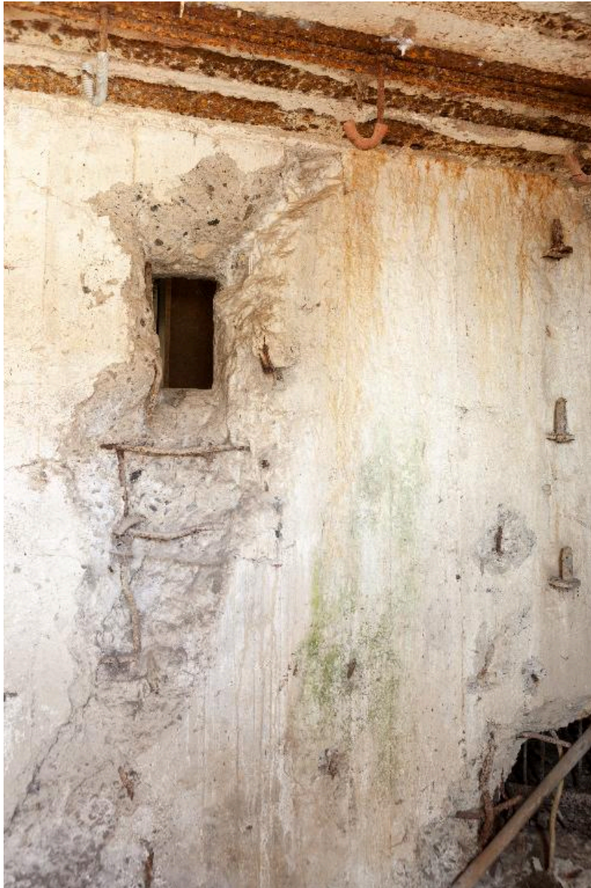
Créneau de fusillade de l'entrée en chicane
