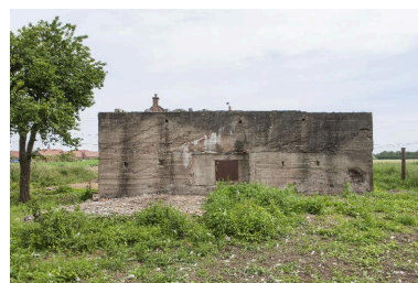
Elévation sud-ouest. L'embrasure de tir, aujourd'hui occultée, est encadrée de créneaux de fusillade. Phot. Jean-Marc Ramette IVR31_20145905581NUCA
