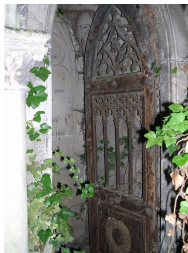
Détail de la porte. Phot. Isabelle Barbedor IVR22_20058002156NUCA
