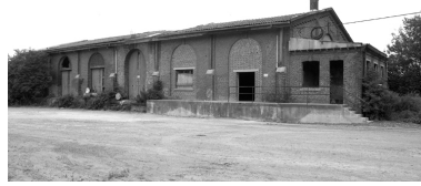
Vue d'ensemble du poste de chargement, depuis le nord-ouest. Phot. Thierry Lefébure IVR22_19920201290Z
