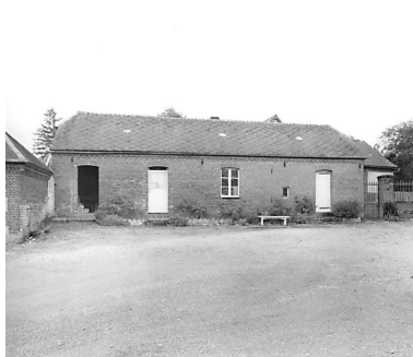
Vue de la remise agricole, 2e moitié 19e siècle. Phot. Laurent Jumel IVR22_19980201004X
