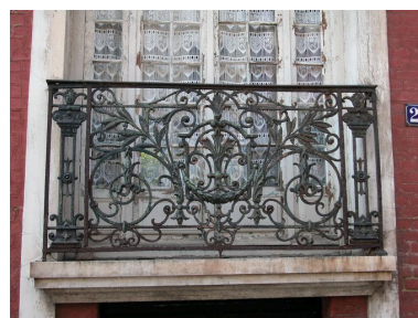
Détail d'un garde-corps en fonte de l'habitation dite Henriette. Phot. Elisabeth Justome IVR22_20058002544NUCA
