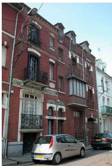
Vue d'ensemble des deux habitations. Phot. Elisabeth Justome IVR22_20058002542NUCA
