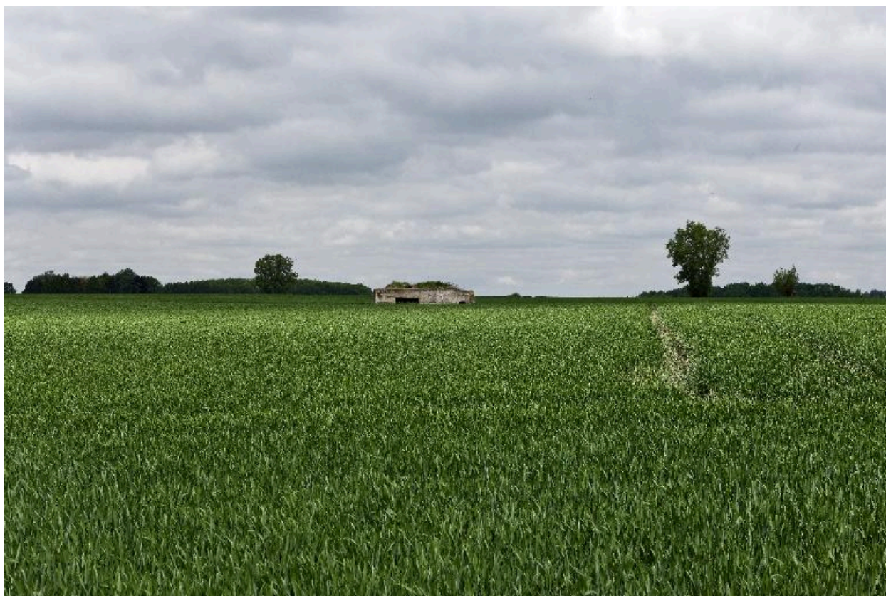
Elévation antérieure, vers le nord ouest
