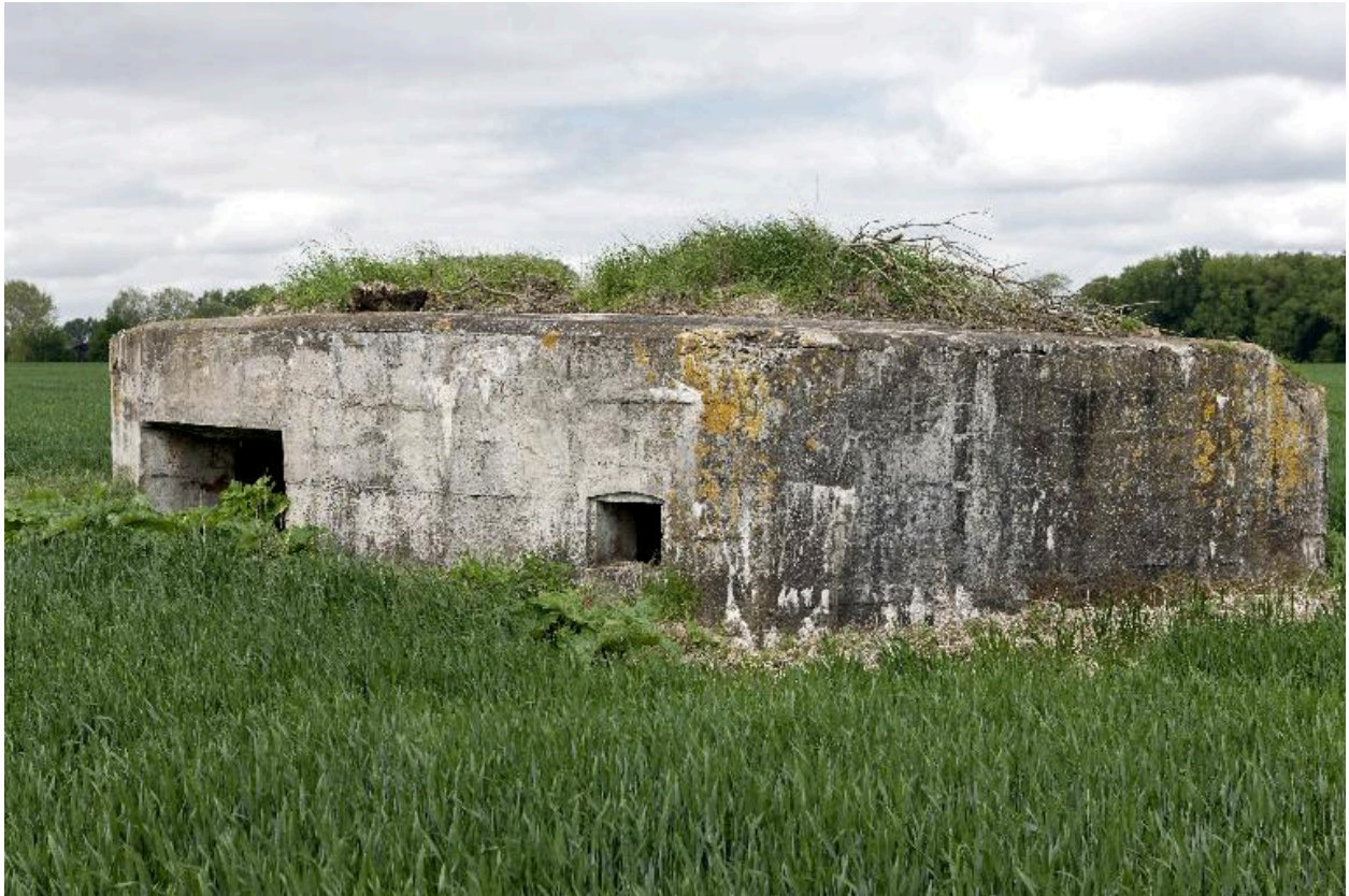
Vue générale, vers le nord-ouest. A gauche l'entrée de la chambre de tir, à droite, ouverture éclairant la soute à munitions.
