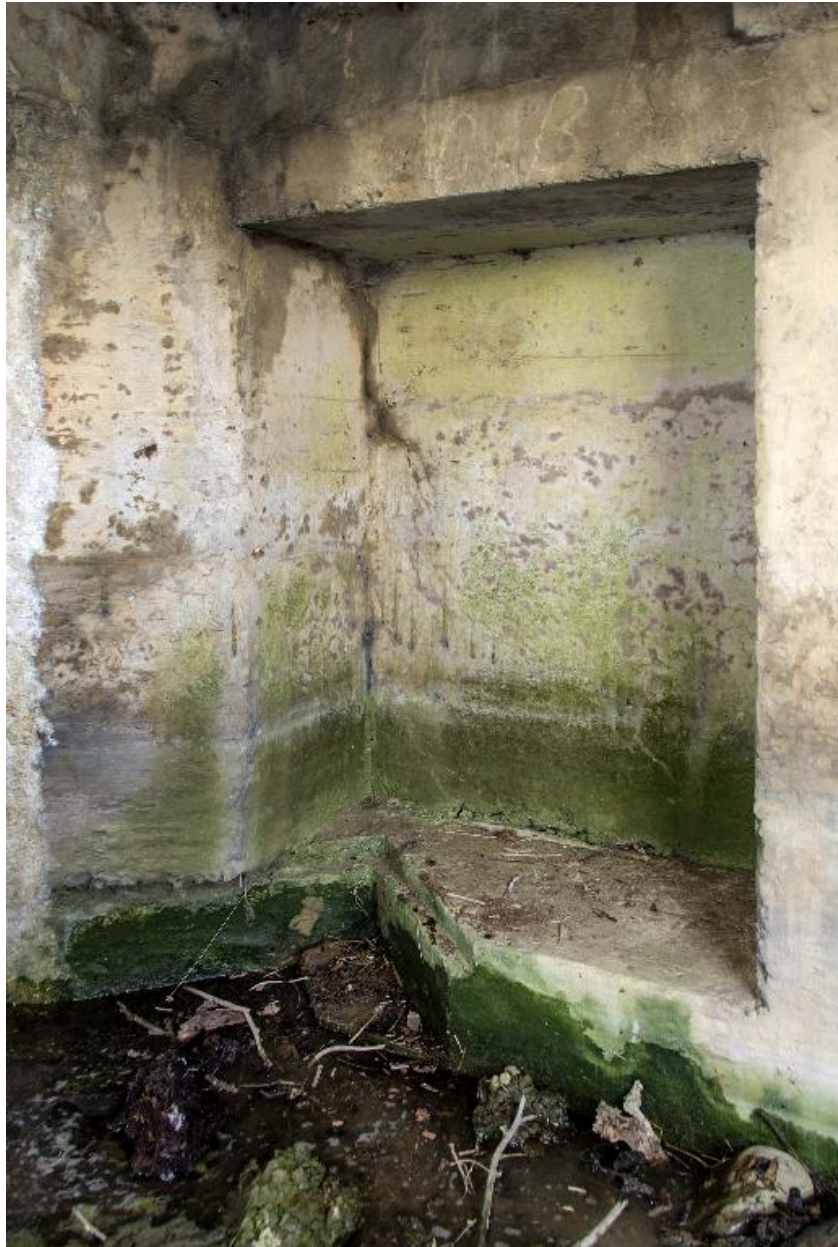
Vue intérieure, paroi est de la chambre de tir. Une entaille à la base du mur permettait, peut-être, d'augmenter le débattement d'une pièce d'artillerie sur un chemin de roulement
