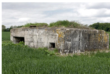
Vue générale, vers le nord-ouest. A gauche l'entrée de la chambre de tir, à droite, ouverture éclairant la soute à munitions. Phot. Jean-Marc Ramette IVR31_20145904728NUCA
