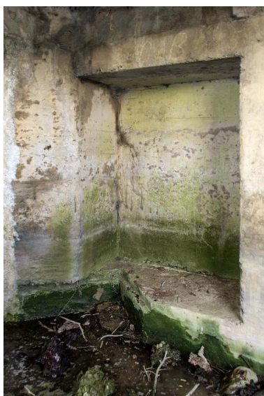
Vue intérieure, paroi est de la chambre de tir. Une entaille à la base du mur permettait, peut-être, d'augmenter le débattement d'une pièce d'artillerie sur un chemin de roulement Phot. Jean-Marc Ramette IVR32_20175900499NUCA
