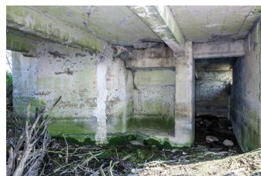
Vue intérieure, paroi est de la chambre de tir et accès à la soute à munition à droite. Phot. Pierre Thibaut IVR31_20155901186NUCA
