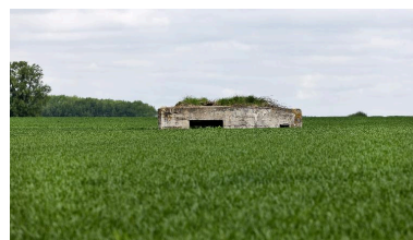
Vue générale, vers le nord-ouest. A gauche l'entrée de la chambre de tir, à droite l'ouverture éclairant la soute à munitions. Phot. Jean-Marc Ramette IVR31_20145904734NUCA
