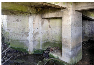
Vue intérieure, paroi est de la chambre de tir et accès à la soute à munition à droite. Phot. Jean-Marc Ramette IVR32_20175900501NUCA
