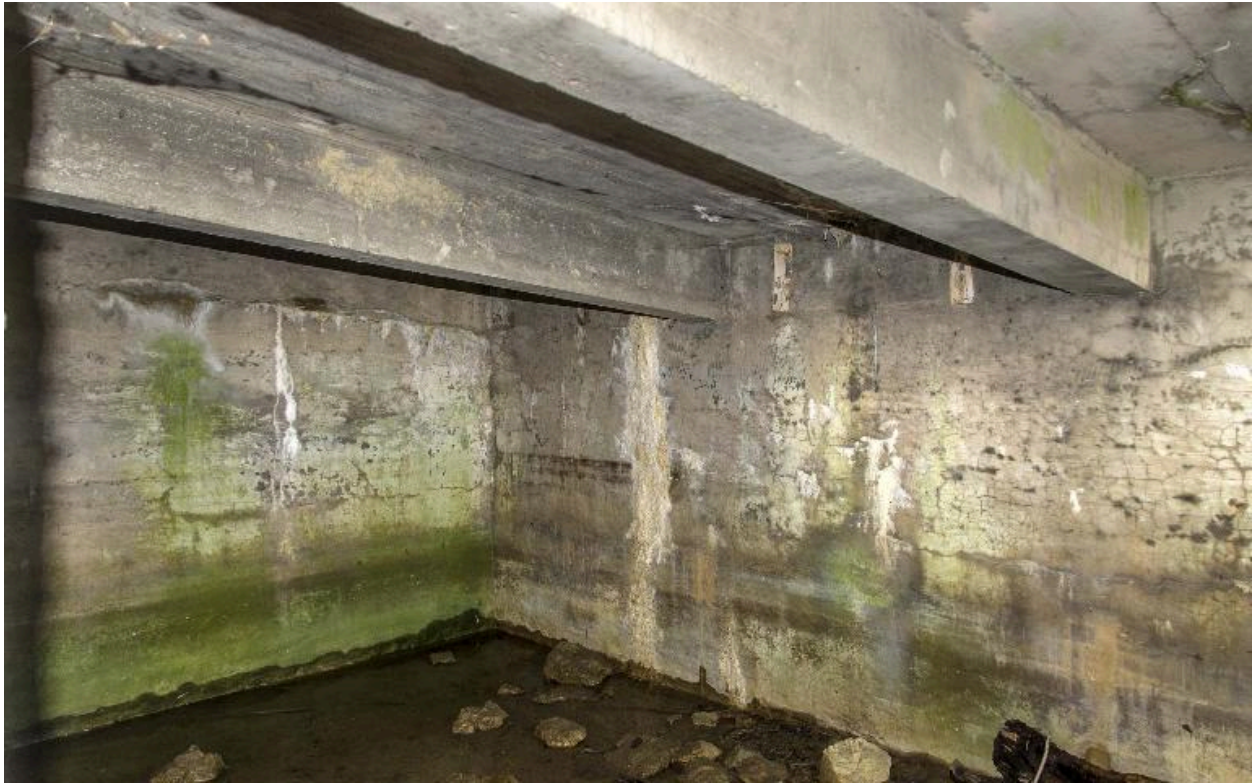
Les poutrelles de la soute à munitions depuis la chambre de tir.
