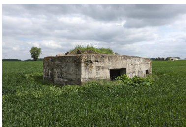
Vue générale, vers le nord-est. A gauche l'entrée de la chambre de tir, à droite l'ouverture éclairant la soute à munitions. Phot. Jean-Marc Ramette IVR31_20145904729NUCA
