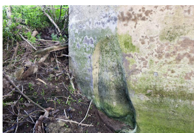
Détail de l'échancrure droite située à la base du mur près de la sortie de la chambre de tir (pour le blocage de l'affût du canon ?) Phot. Pierre Thibaut IVR31_20155901185NUCA
