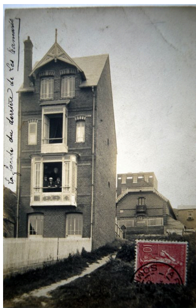
La façade sur mer, carte photo, 1er quart 20e siècle (coll. part.) Phot. Monnehay-Vulliet Marie-Laure IVR22_20058000619XAB
