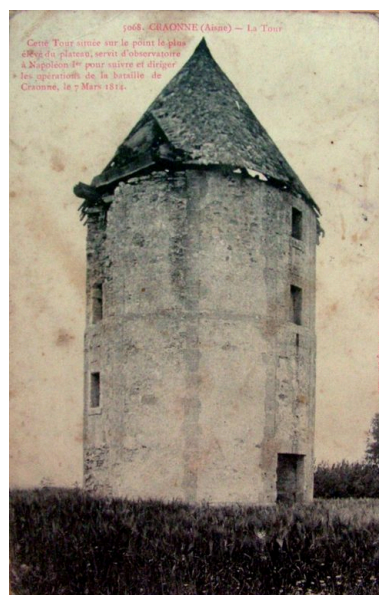
Vue de la tour de Craonne (coll. part). Phot. Inès Guérin IVR22_20030202652NUCAB
