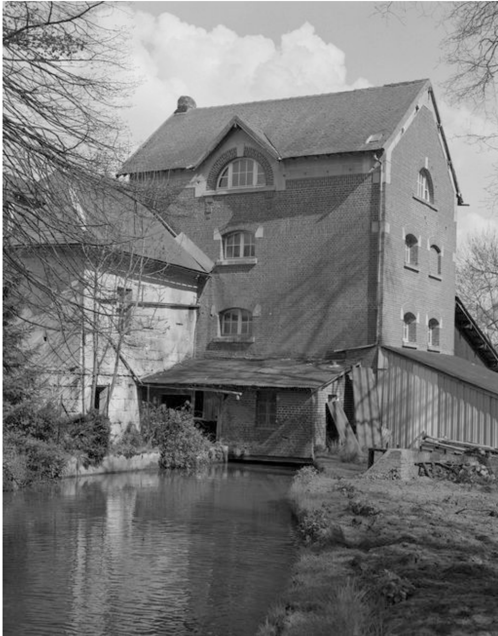
Elévation latérale du moulin.
