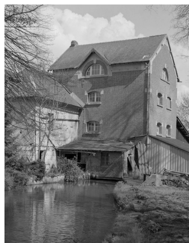
Elévation latérale du moulin. Phot. Jean-Michel Perrin IVR22_19856000627X
