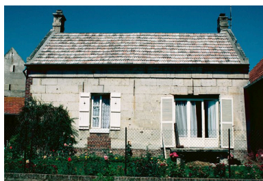
Elévation postérieure du logis d'une ferme repérée. Phot. Alain Nafilyan IVR22_19856001307ZA
