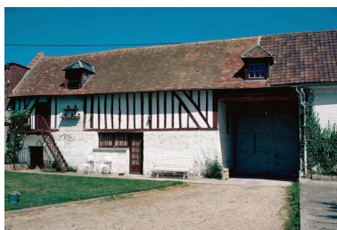
Elévation antérieure de la grange d'une ferme repérée. Phot. Alain Nafilyan IVR22_19856001306ZA
