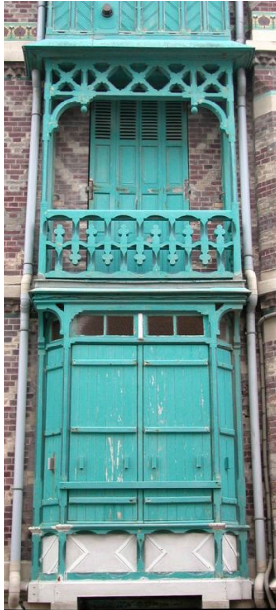
Détail du bow-window surmonté d'un balcon de la maison Les Chardons.
