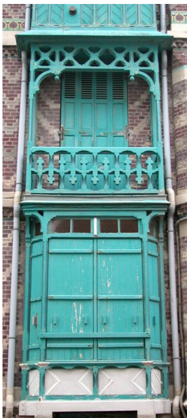
Détail du bow-window surmonté d'un balcon de la maison Les Chardons. Phot. Elisabeth Justome IVR22_20048001449NUCA
