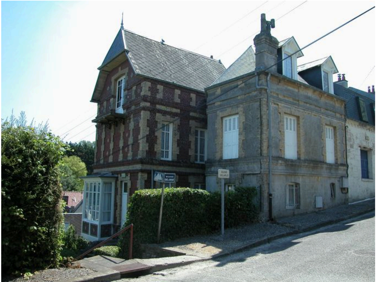
Vue d'ensemble depuis le boulevard Delarue.
