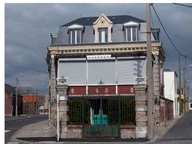
Élévation antérieure. Phot. Elisabeth Justome IVR22_20058003074NUCA
