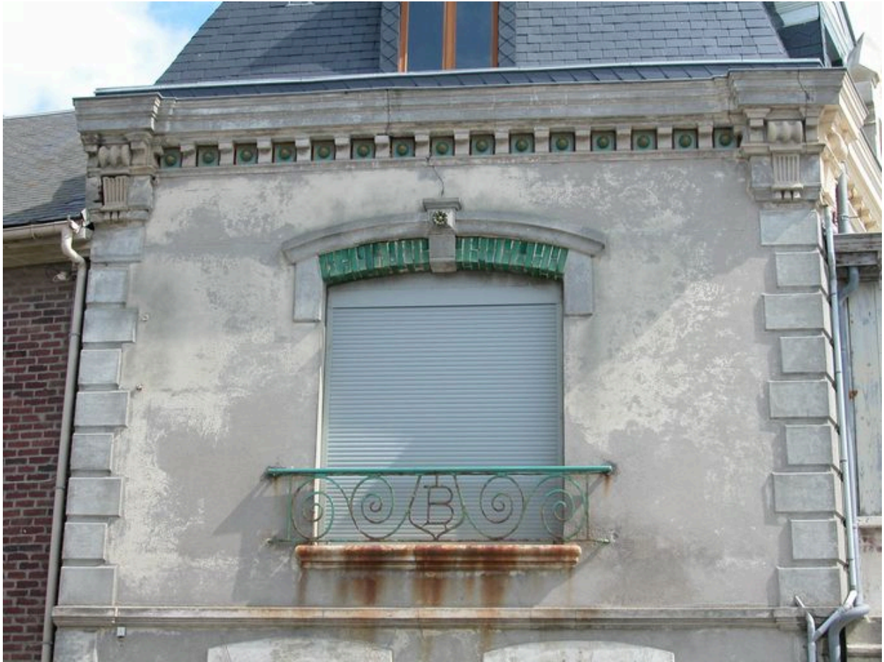
Détail de la baie avec garde-corps en fonderie, façade latérale gauche.
