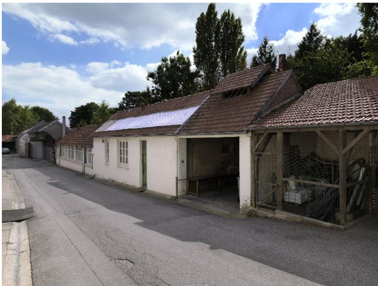
Vestiaires et anciens ateliers de fabrication.
