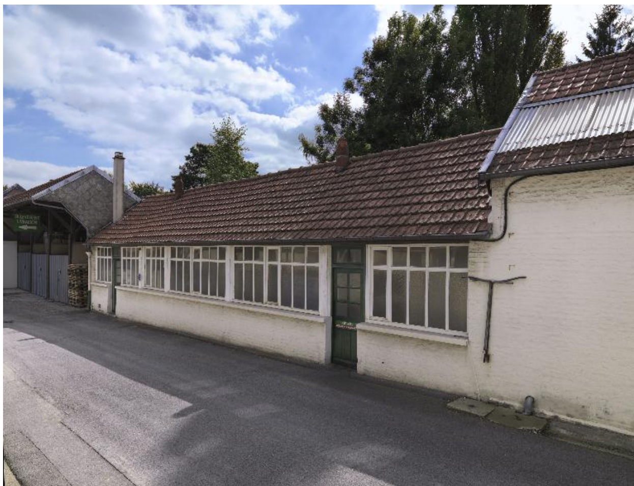
Anciens ateliers de fabrication, aujourd'hui vestiaires.
