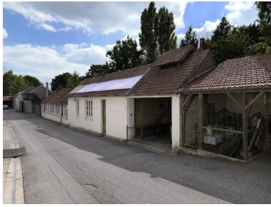
Vestiaires et anciens ateliers de fabrication. Phot. Thierry Lefébure IVR22_20158000822NUC2A
