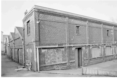
Ateliers de fabrication. Phot. Benoît Dufournier IVR22_19936002437Z
