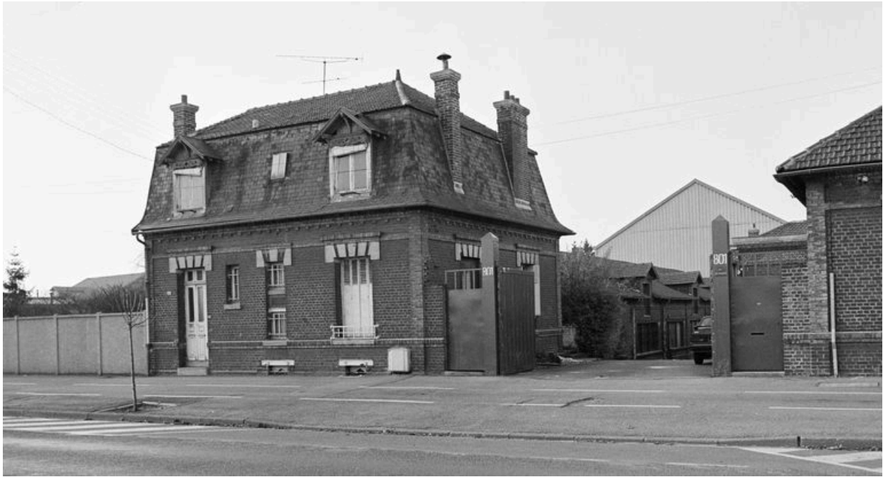
Conciergerie : élévation antérieure.
