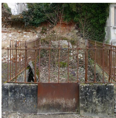
Clôture à mur bahut, vers 1846 (G 108). Phot. Caroline Vincent IVR22_20068000668NUCA
