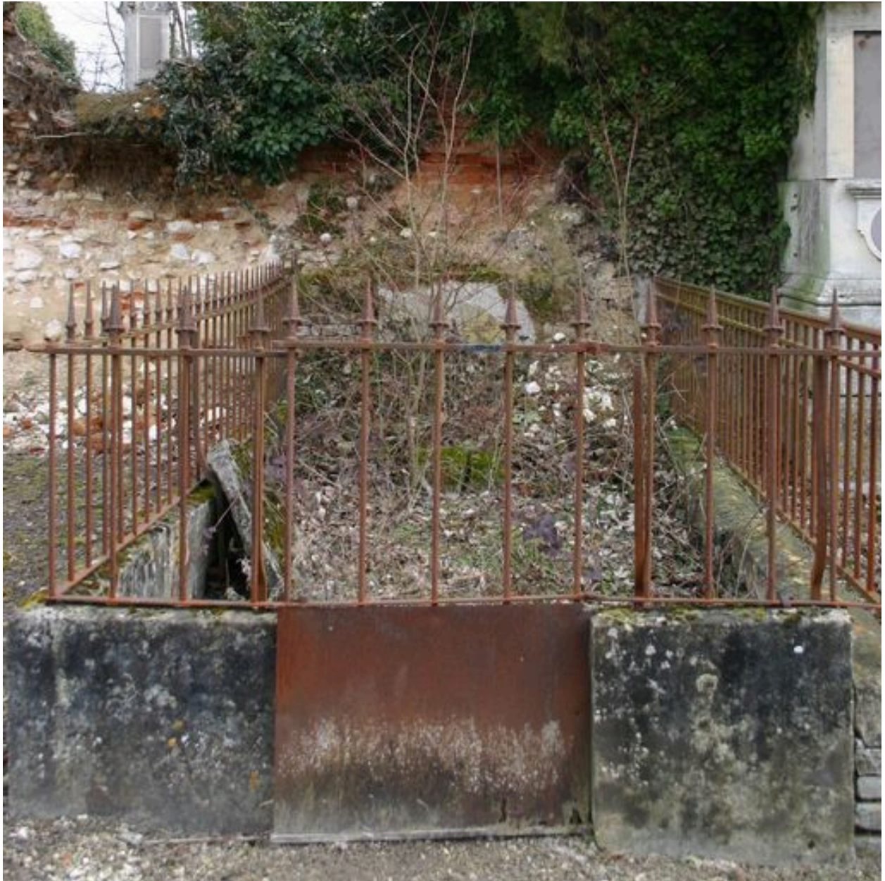
Clôture à mur bahut, vers 1846 (G 108).
