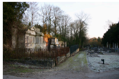
Vue générale du premier mur d'enceinte intérieur, vers l'est. Phot. Caroline Vincent IVR22_20098001675NUCA
