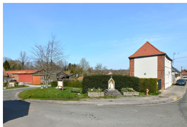
Vue de situation de l'oratoire sur la place de Cuhem. Phot. Thierry Lefébure IVR32_20236200567NUCA
