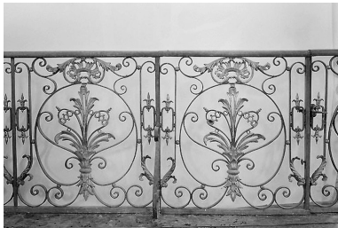
Vue générale. Phot. Laurent Jumel IVR22_19970201751X
