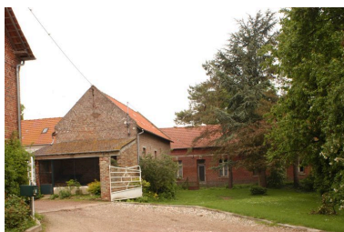
Dépendances est, à gauche de l'image. Phot. Thierry Lefébure IVR22_20038000423NUCA
