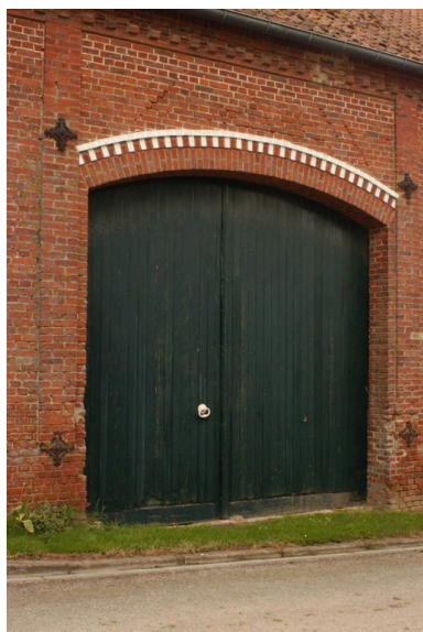
Dépendances : détail sur le portail. Phot. Thierry Lefébure IVR22_20038000424NUCA
