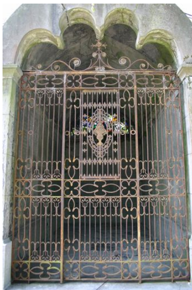
Grille monumentale en fonte, fermant l'entrée du tombeau. Phot. Caroline Vincent IVR22_20068000810NUCA
