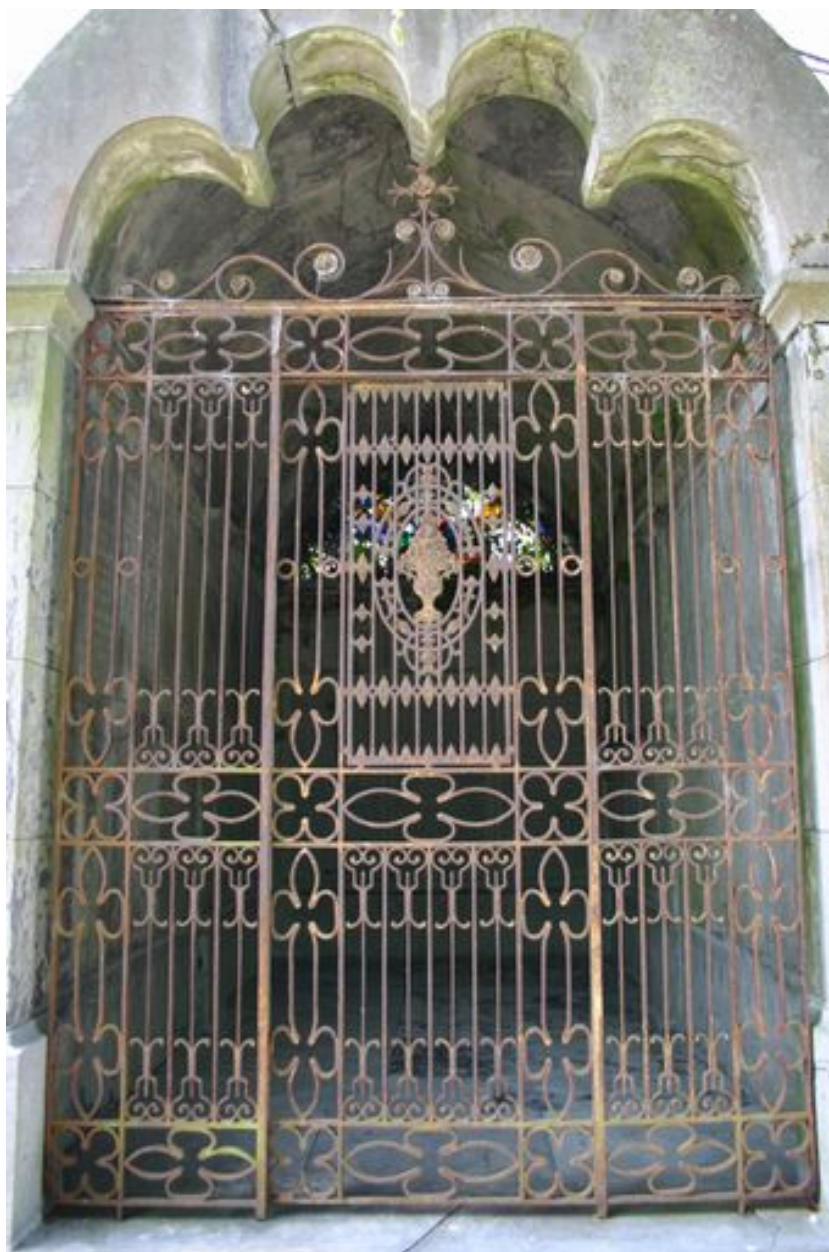
Grille monumentale en fonte, fermant l'entrée du tombeau.
