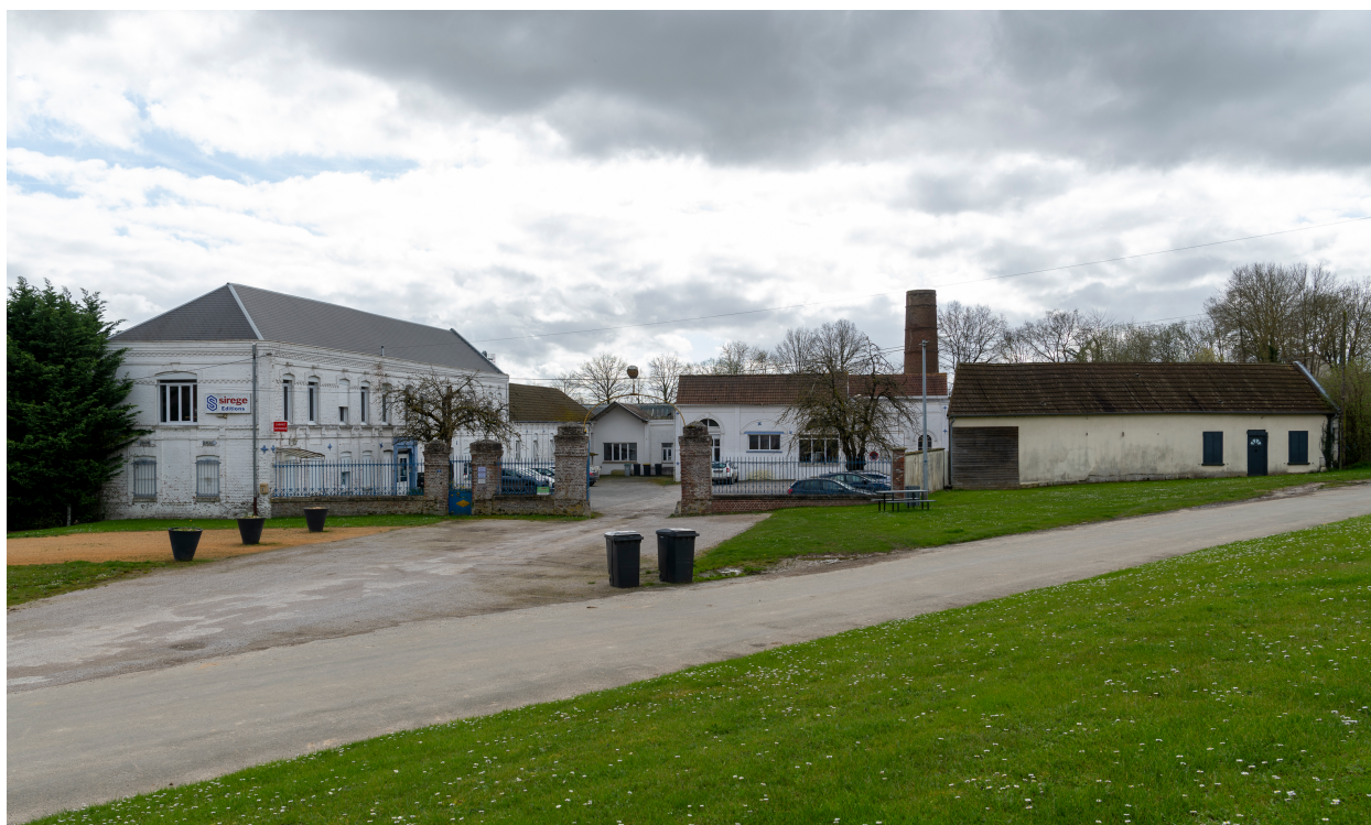
Vue générale de l'usine depuis le nord.
