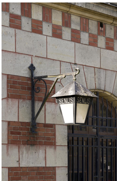
Détail d'une des anciennes lanternes éclairant les quais. Phot. Thierry Lefébure IVR32_20216001284NUCA
