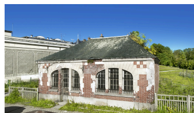
Dépendance de la gare. Phot. Thierry Lefébure IVR32_20216001304NUCA
