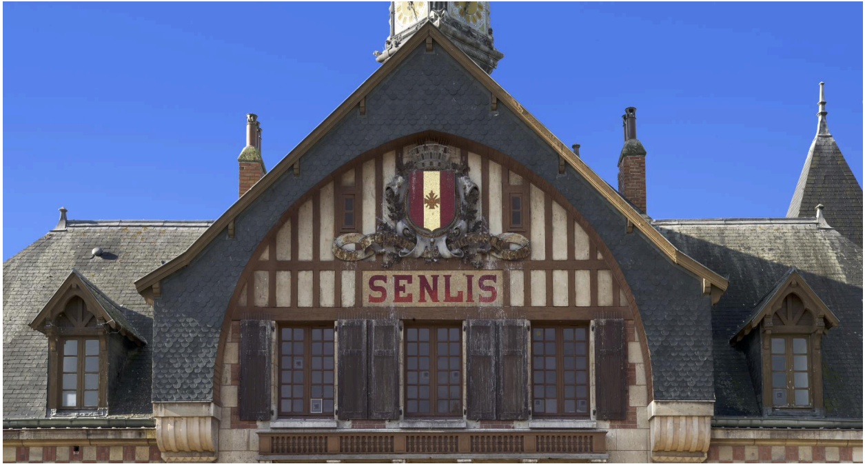
Fronton de la façade nord donnant sur les voies.
