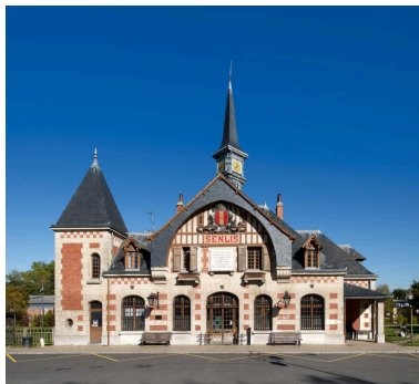
Vue d'ensemble de face de la façade donnant sur la place de la Gare. Phot. Thierry Lefébure IVR32_20216001286NUCA
