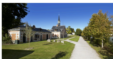
Vue d'ensemble depuis l'ancienne voie ferrée transformée en voie verte. Phot. Thierry Lefébure IVR32_20216001306NUCA
