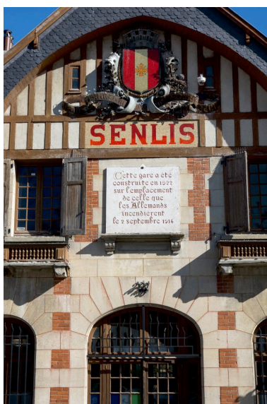
Détail du fronton de la gare portant les armes de la ville de Senlis et l'inscription rappelant les circonstances et la date de la reconstruction. Phot. Thierry Lefébure IVR32_20216001291NUCA
