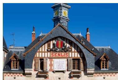
Détail du fronton de la gare portant les armes de la ville de Senlis et l'inscription rappelant les circonstances et la date de la reconstruction. Phot. Thierry Lefébure IVR32_20216001296NUCA
