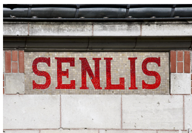
Détail de l'inscription de la ville sur le pignon de la gare. Phot. Thierry Lefébure IVR32_20216001285NUCA
