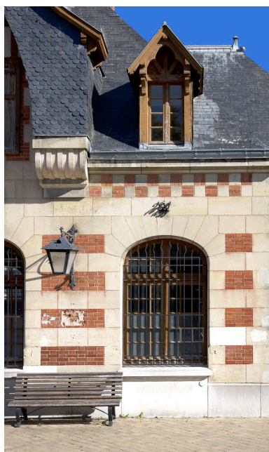
Détail d'une des ouvertures en plein cintre au rez-de- chaussée de la façade principale. Phot. Thierry Lefébure IVR32_20216001293NUCA
