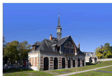
Façade donnant sur les anciennes voies ferrées, vue de trois-quarts. Phot. Thierry Lefébure IVR32_20216001279NUCA
