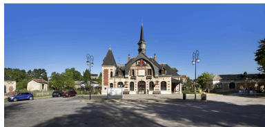
Vue d'ensemble de la place de la gare. Phot. Thierry Lefébure IVR32_20216001301NUCA
