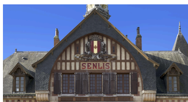
Fronton de la façade nord donnant sur les voies. Phot. Thierry Lefébure IVR32_20216001282NUCA
