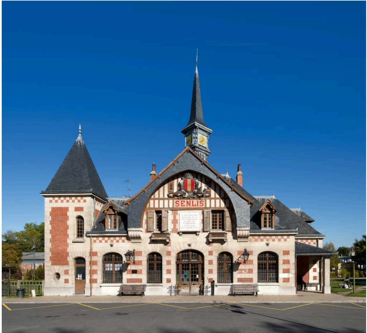
Vue d'ensemble de face de la façade donnant sur la place de la Gare.
