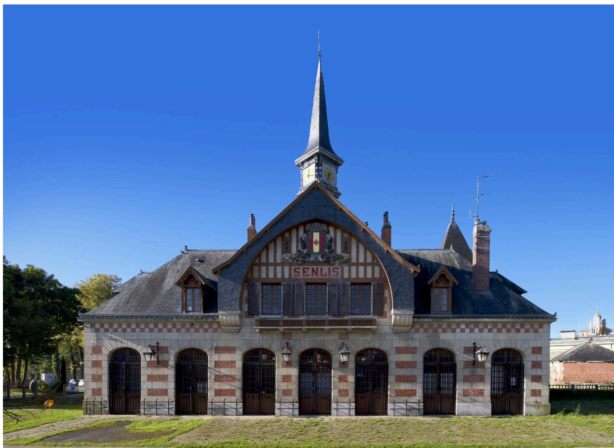
Façade de la gare donnant sur les anciennes voies, vue de face.
