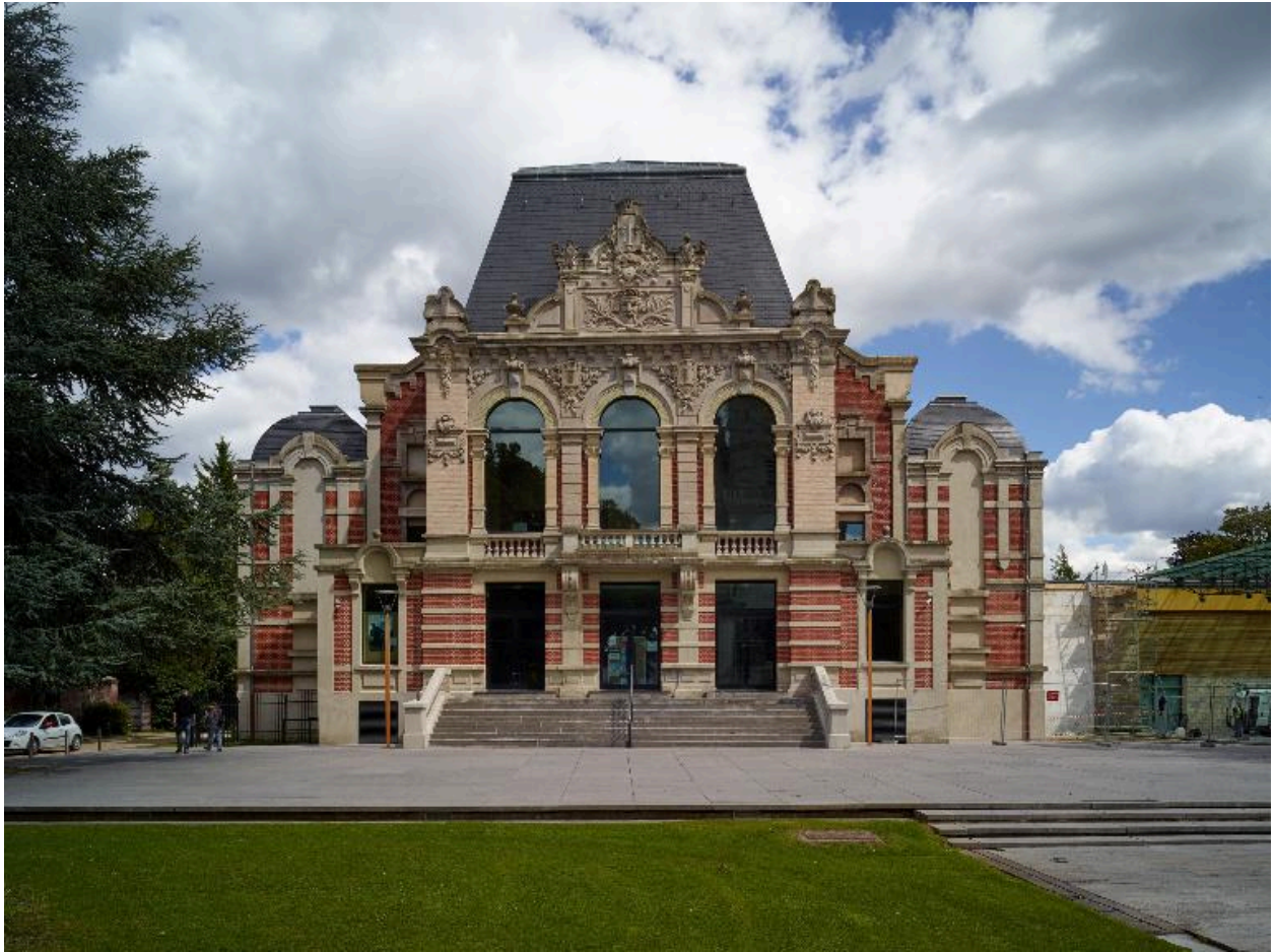
Vue générale depuis le jardin public.
