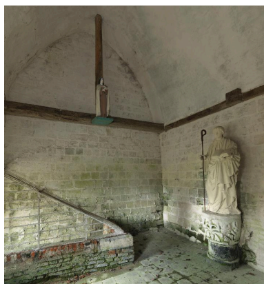
Vue intérieure, partie ouest. Phot. Thierry Lefébure IVR22_20128001166NUC2AQ
