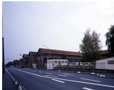
Le site vu depuis la rue de Guise. Phot. Thierry Lefébure IVR22_20070200051VA
