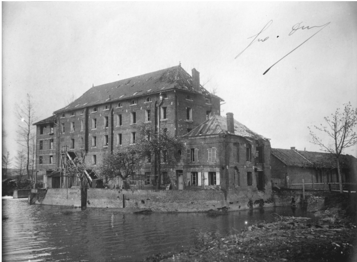
L'usine de Lucy à Ribemont, vers 1919 (AD Aisne).
