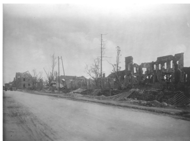
Les ruines de l'usine Daltroff vue depuis la rue de Guise, vers 1919 (AD Aisne). Phot. Pillet Frédéric IVR22_20050206582NUCAB
