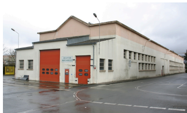
Entrepôt industriel de 1949. Phot. Frédéric Pillet IVR22_20060205250NUCA
