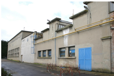
Pignons orientaux des ateliers. Phot. Frédéric Pillet IVR22_20060205244NUCA
