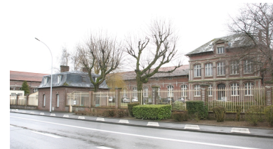
Le site vu depuis la rue de Guise. Phot. Frédéric Pillet IVR22_20060205237NUCA
