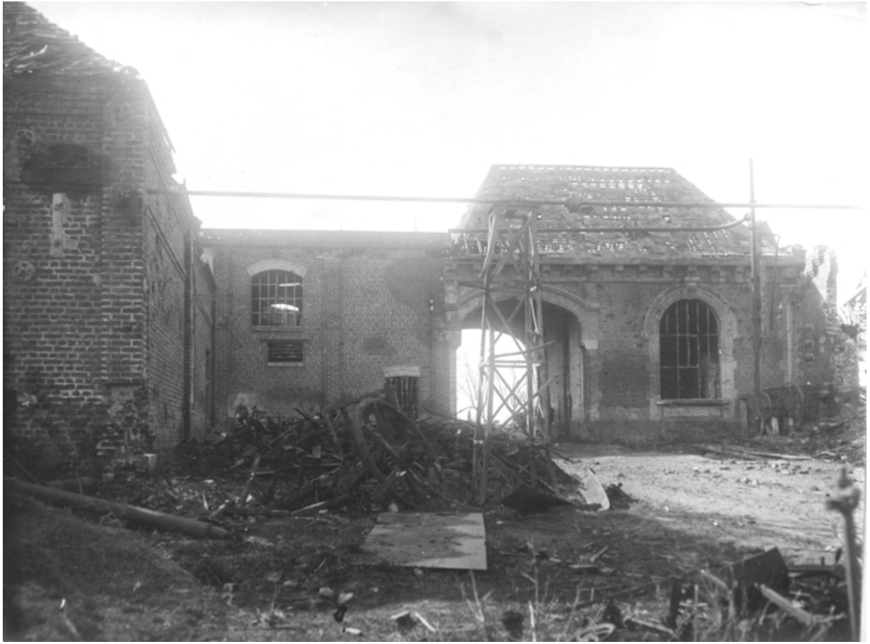
Salle des machines (à droite) et chaufferies, vers 1919 (AD Aisne).
