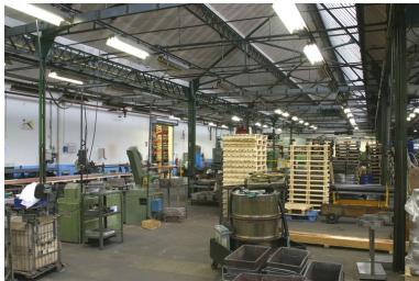
Vue intérieure des ateliers de 1920. Phot. Frédéric Pillet IVR22_20060205241NUCA
