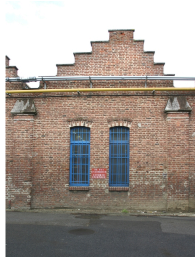
Un pignon à redents des ateliers de 1920. Phot. Frédéric Pillet IVR22_20060205240NUCA
