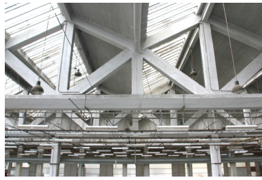
Vue intérieure des ateliers de 1949 : détail de la charpente. Phot. Frédéric Pillet IVR22_20060205248NUCA
