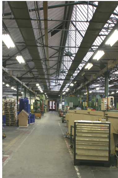
Vue intérieure des ateliers de 1920. Phot. Frédéric Pillet IVR22_20060205242NUCA
