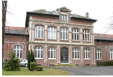
Façade antérieure des anciens bureaux. Phot. Frédéric Pillet IVR22_20060205239NUCA
