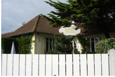
Vue générale. Phot. Julie Faure IVR31_20066200149NUCA
