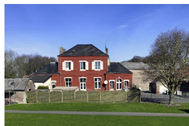
Façade postérieure. Phot. Thierry Lefébure IVR22_20158000088NUC2A
